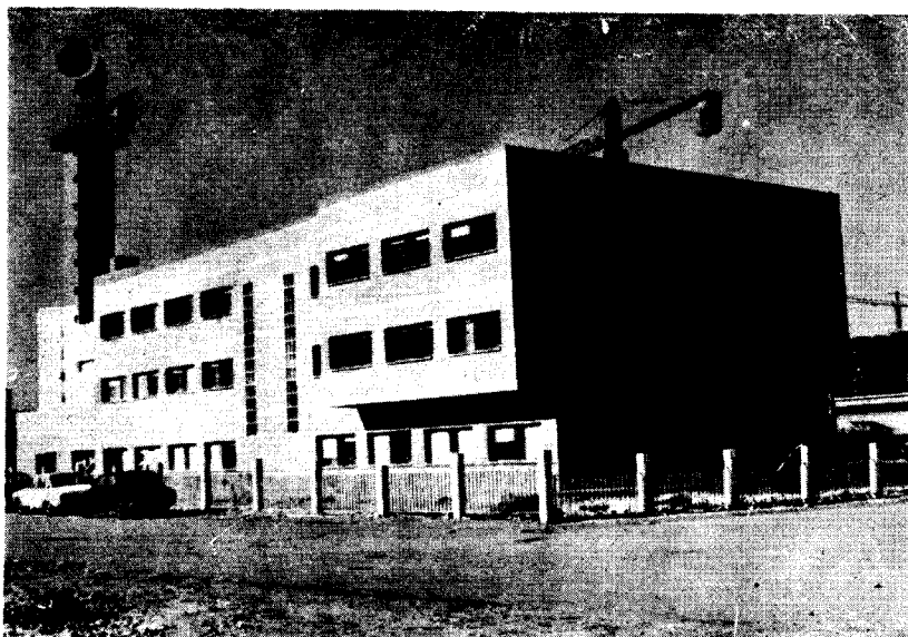
Aspecto del módulo que se construye en el polígono «La Granja», de Ciudad Real.
