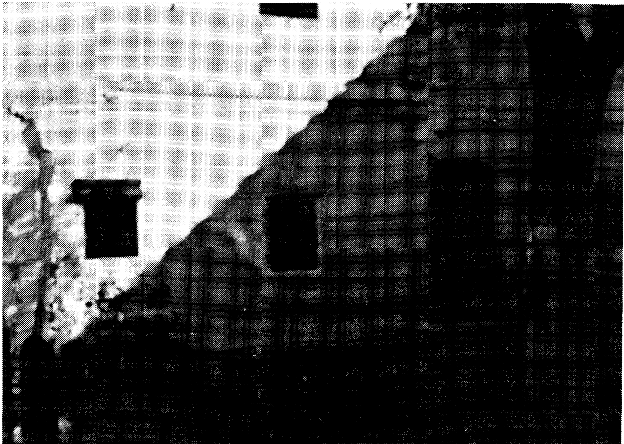
Patio de una vieja casa hidalga de Ciudad Real
