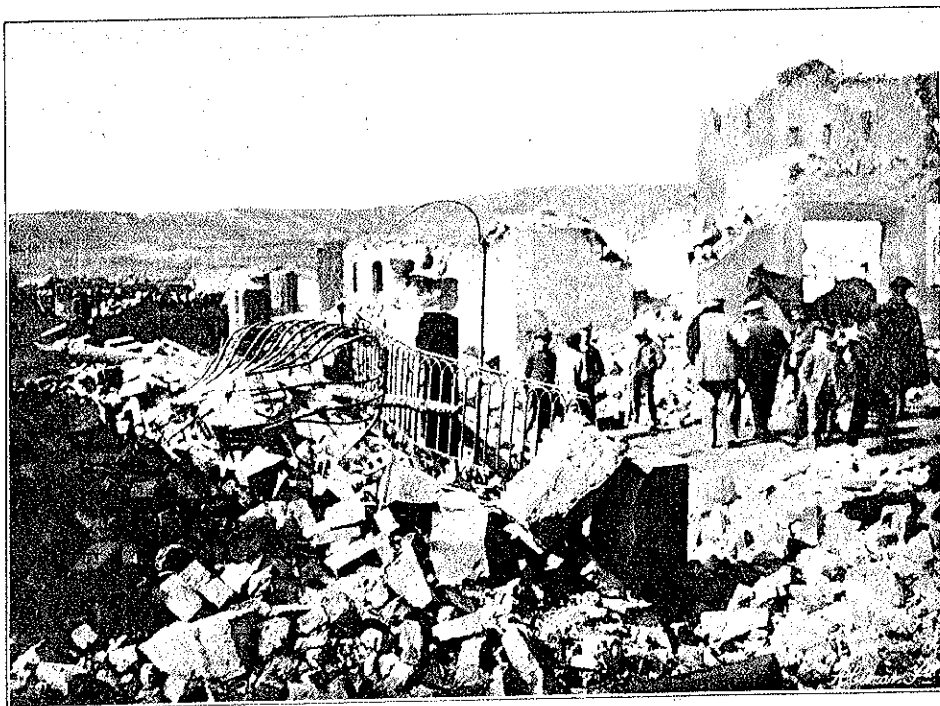
ASPECTO DEL PUEBLO EN RUINAS
