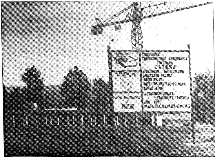
Terrenos del Salto del Caballo donde se instalara el complejo. (Foto: J.L. Pérez)
