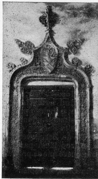
PUERTA DEL CRUCERO AL PATIO
