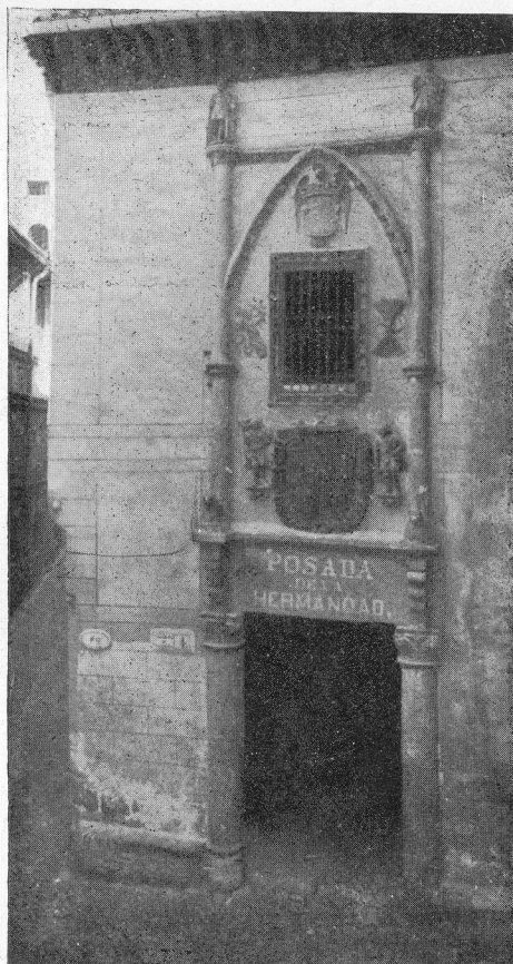
FACHADA DE LA POSADA DE LA HERMANDAD
