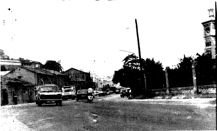
Esta conocida vista del Paseo de la Rosa cambiará muy pronto de aspecto en virtud de las obras de trazado de la nueva autovía que enlazarán con el puente nuevo de Safont.
