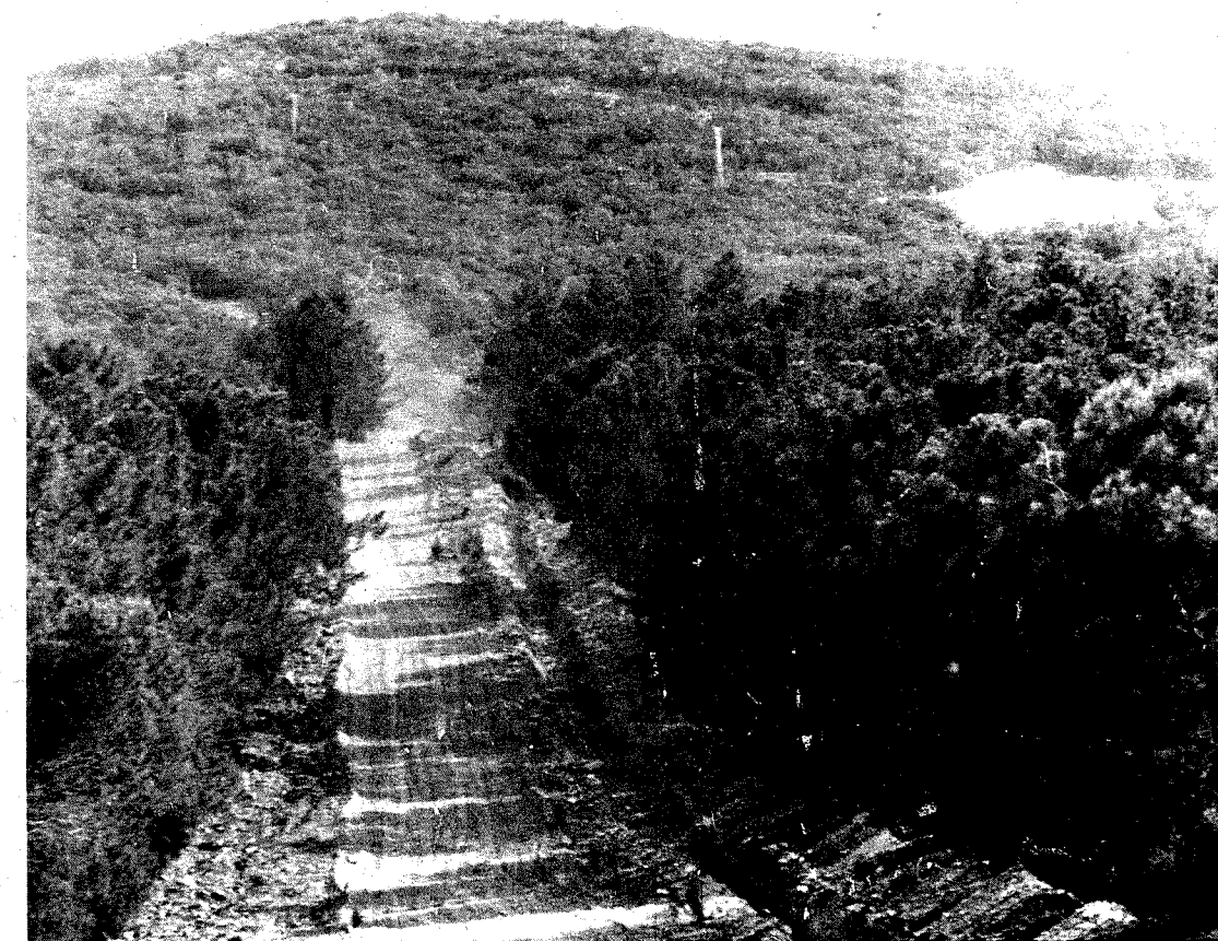
Camino que da acceso al túnel visible a la derecha de la fotografía. Para hacerlo ha sido necesario cortar una gran cantidad de pinos.
