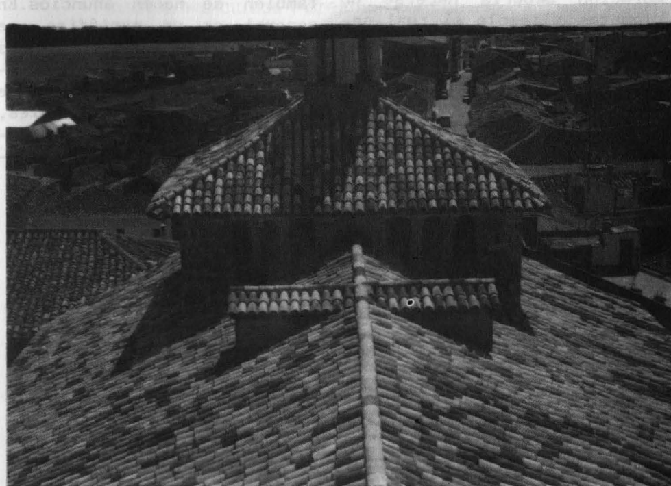
ESTADO ACTUAL DE LA CUBIERTA.
