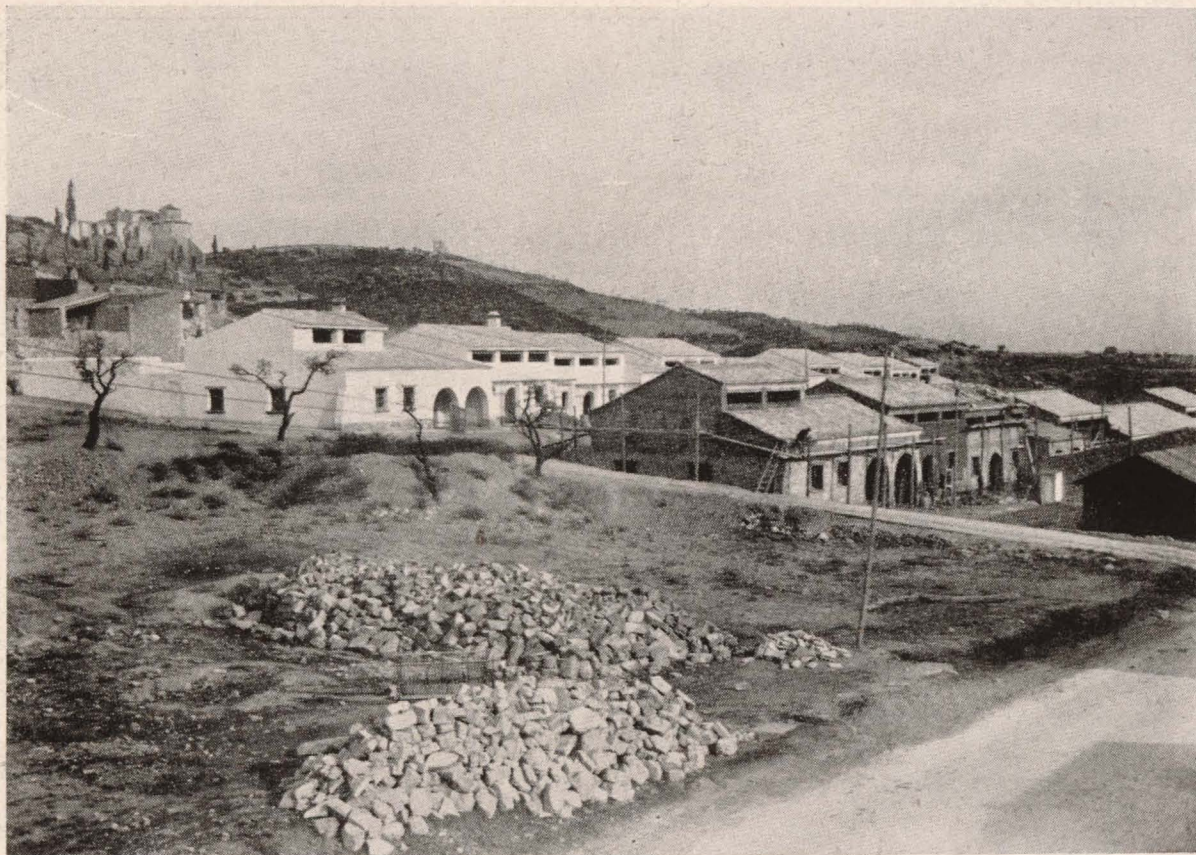
Conjunto de las manzanas, en construcción.
