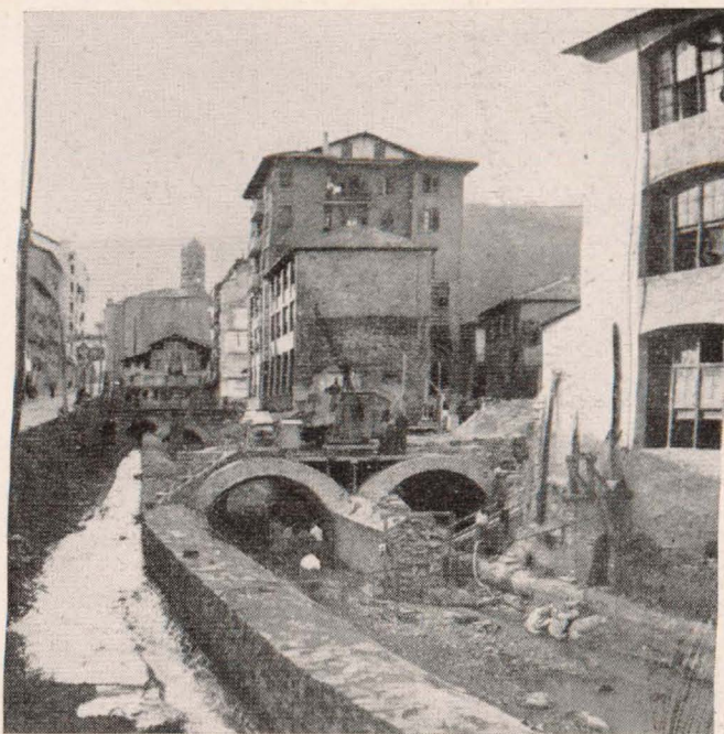
EIBAR.—Colocación de cimbras. A la derecha: Los dos primeros tramos de la bóveda terminados. Abajo: Detalle de un tramo terminado.
