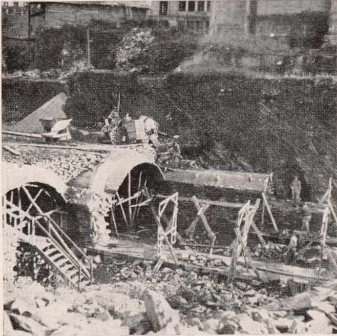
EIBAR.—Las bóvedas del cubrimiento al pie de la Iglesia. A la derecha: Hormigonado de un tramo. Abajo: Aspecto interior del cubrimiento.
