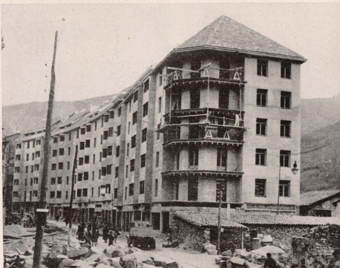
EIBAR.—El bloque de viviendas en marzo de 1944.
