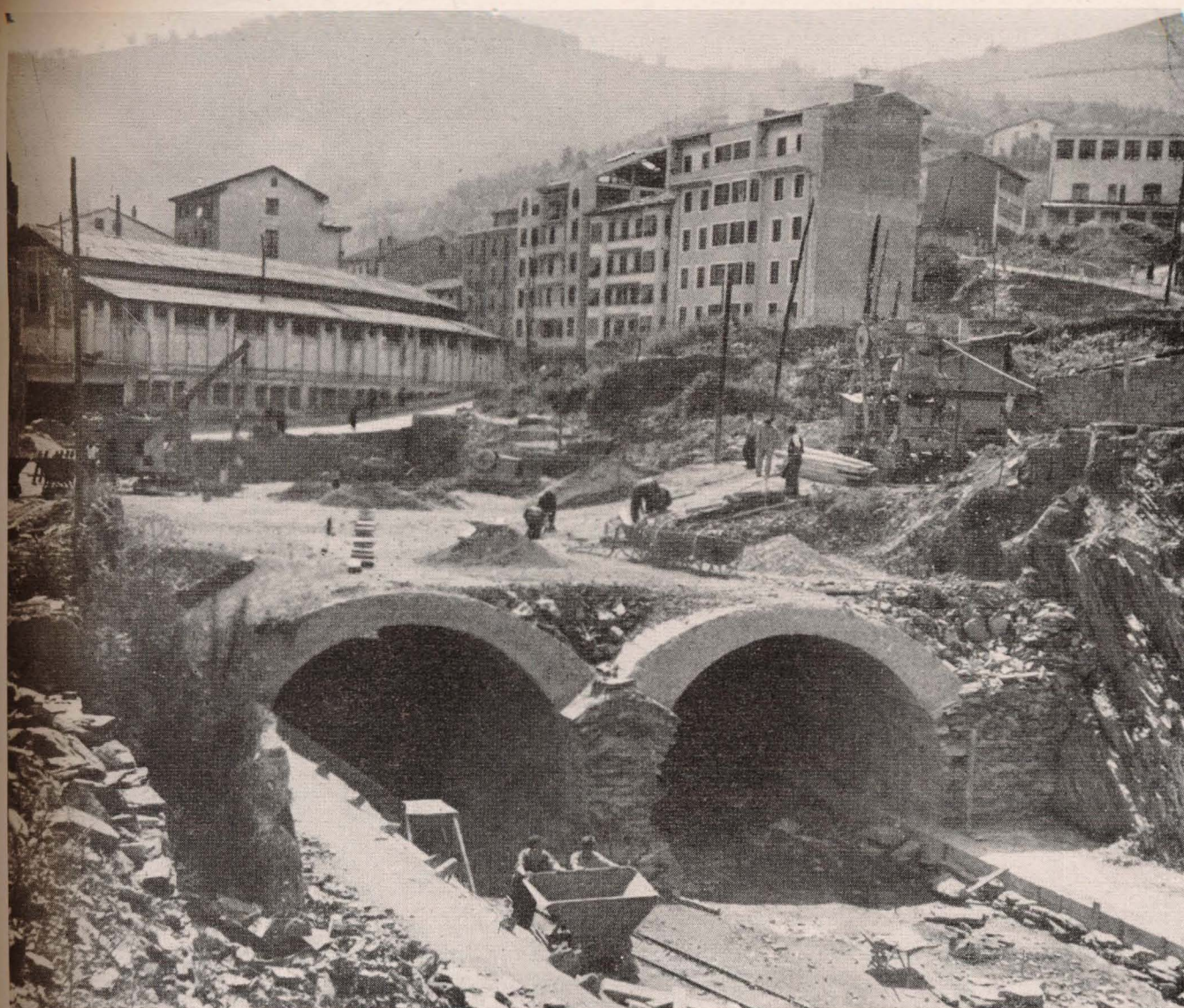
EIBAR.—Colocación de cimbras. A la derecha: Los dos primeros tramos de la bóveda terminados. Abajo: Detalle de un tramo terminado.
