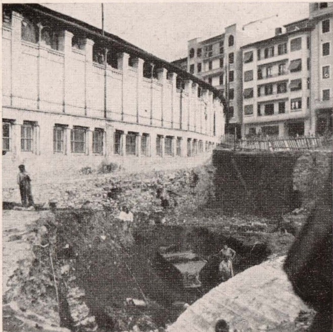
EIBAR.—La excavación llega hasta el Mercado viejo. A la derecha: Cauce antiguo del río al comenzar los trabajos. Se ve en la fotografía una de las pasarelas y un trozo del cubrimiento viejo.
