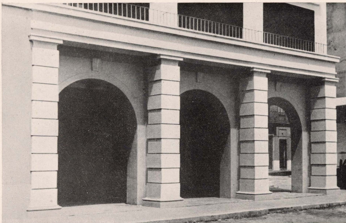
Esquina Noreste. Detalle de fachada.
