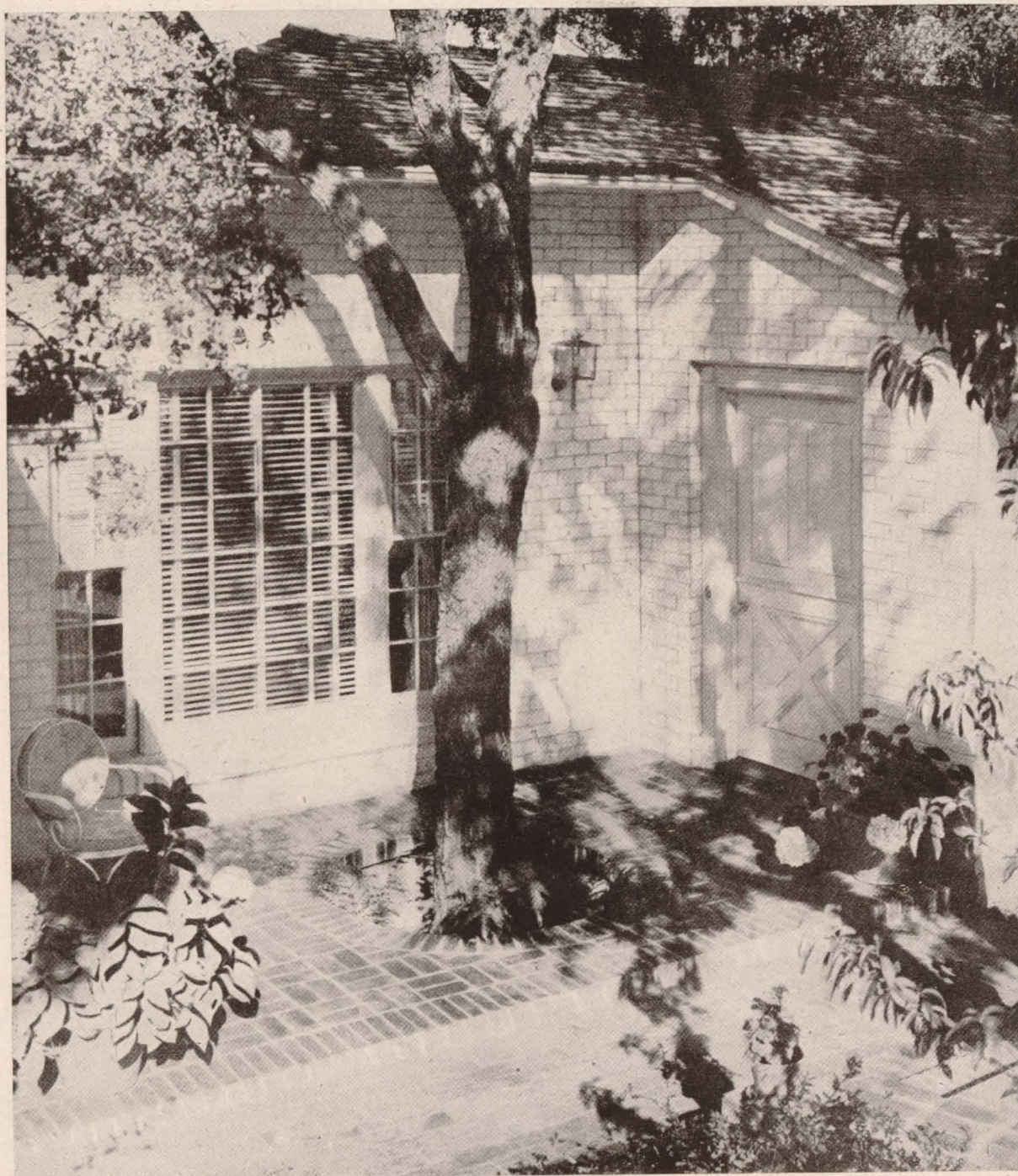
Residencia en Beverly Hills. Detalle. (Arqs.: Marston & Maybury.)
