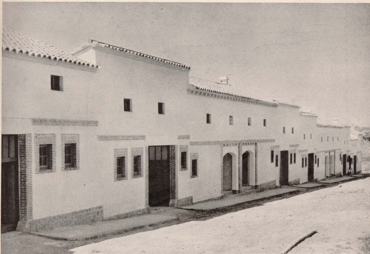
Fachadas de viviendas del tipo A.
