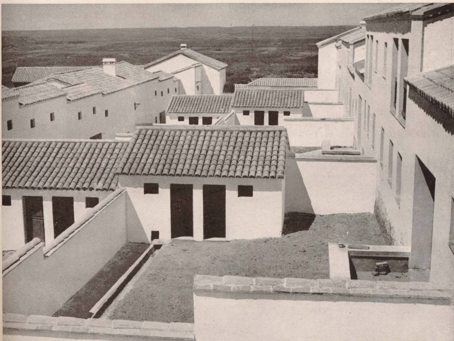
Aspecto del centro de una manzana.
