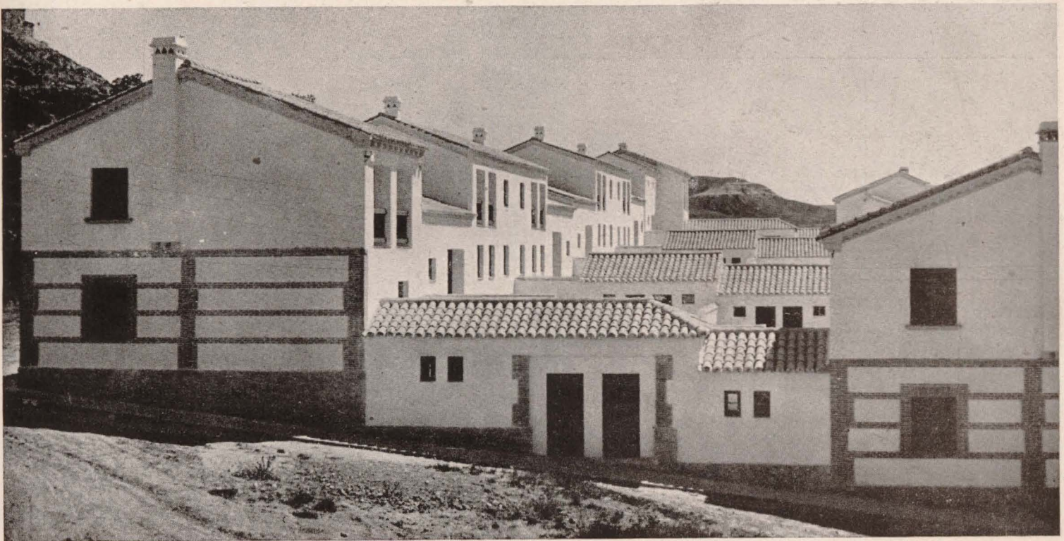
Conjunto de viviendas de una manzana terminada.
