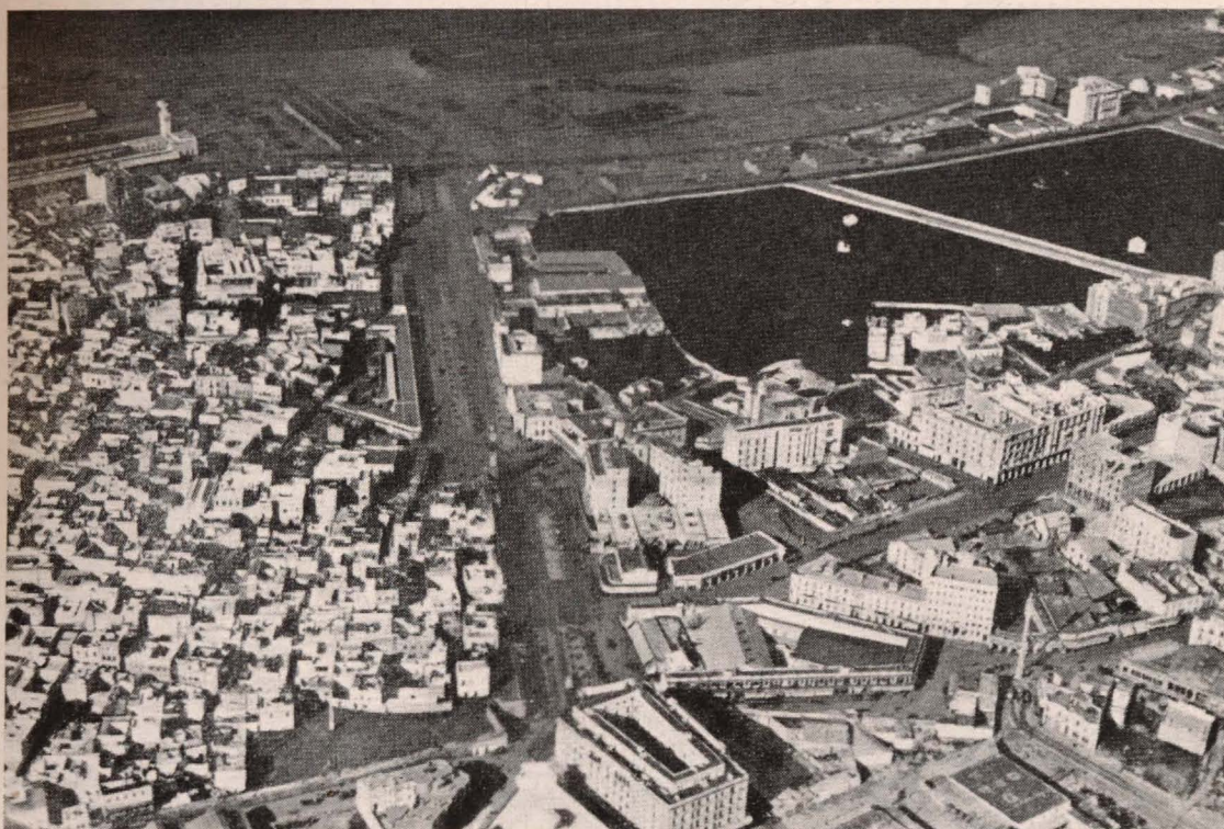
CASABLANCA.—Urbanización de la Zona cuarta. Arquitecto: J. Marrast.
