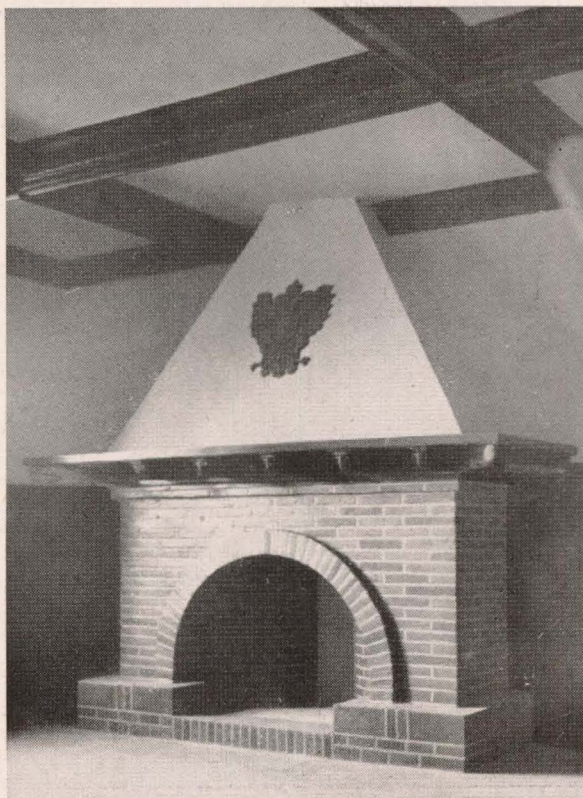
Detalle de una chimenea.
