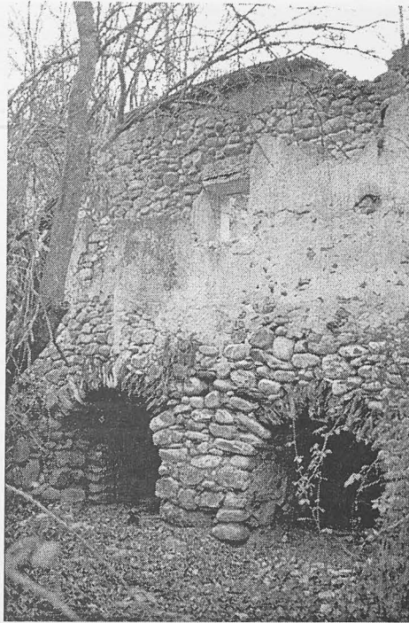
Foto 3 PUEBLA DE VALLES. MOLINO DE VICENTE El edificio es de canto rodado y adobe, todo ello enlucido.
