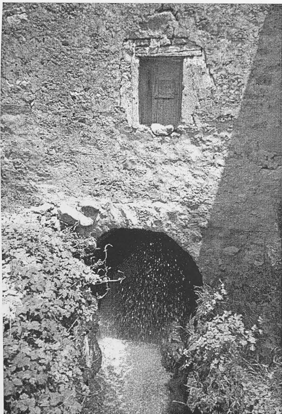
Foto 14 VALDECUBOS. MOLINO DEL PUEBLO El agua penetra en el molino y sale por el cárcavo...
