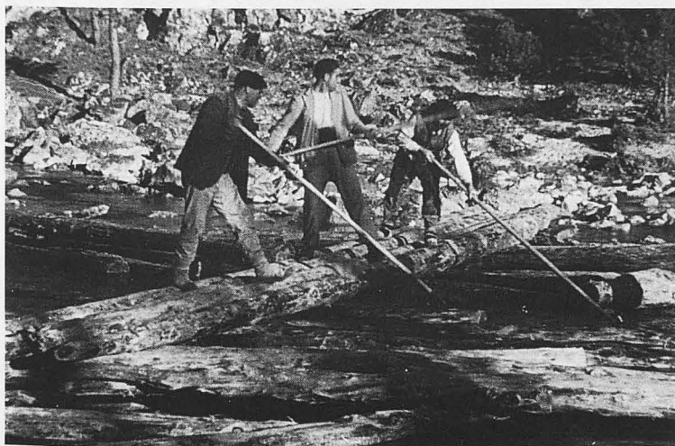
LAMINA V: Pasarela de troncos sobre un adobo y forma de trabajar sobre ella (NODO, 1944) Cortesía de Filmoteca Española.
