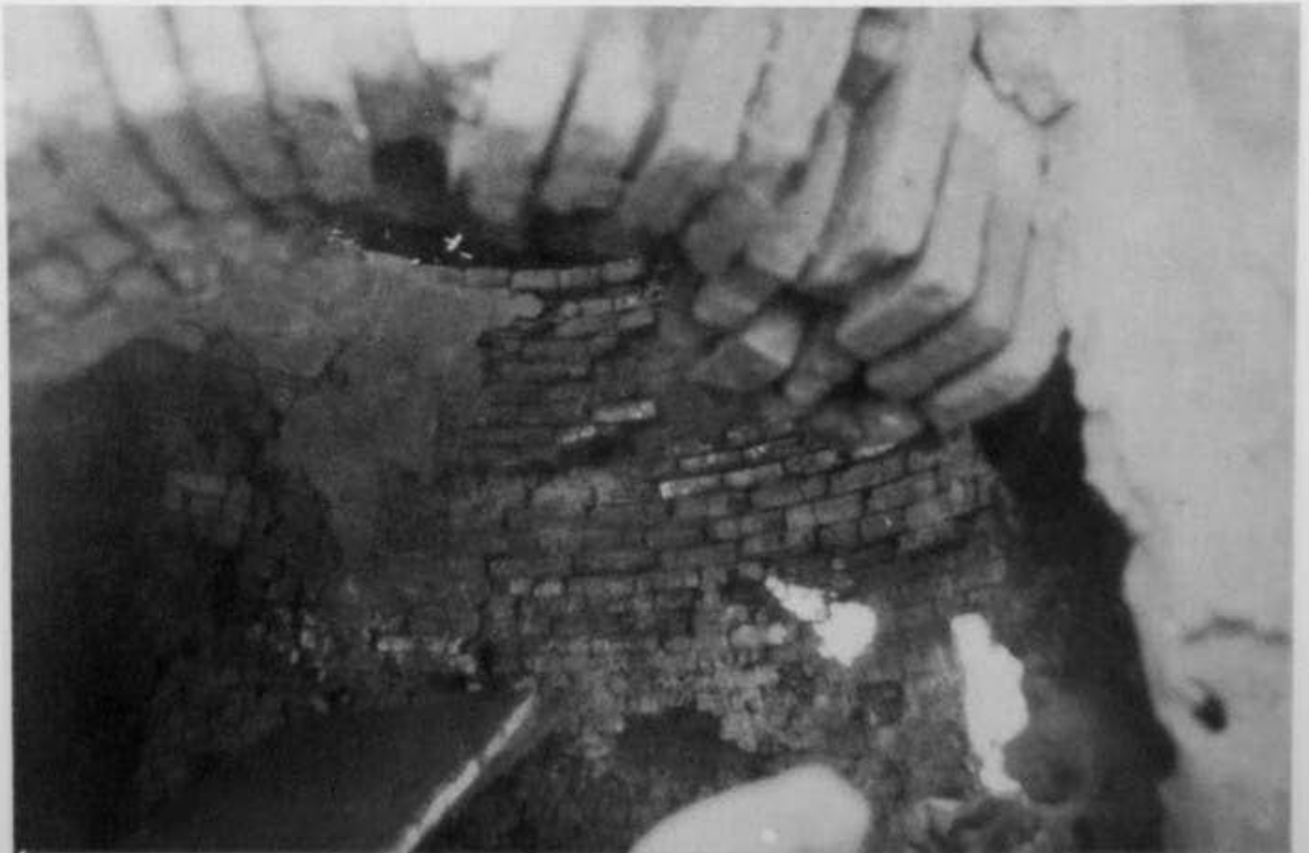
Fot. n.º 6: Interior de la cámara del horno árabe de los hermanos Tortosa.
