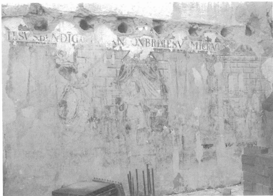
Fot. 7.- Pinturas del panel principal.
