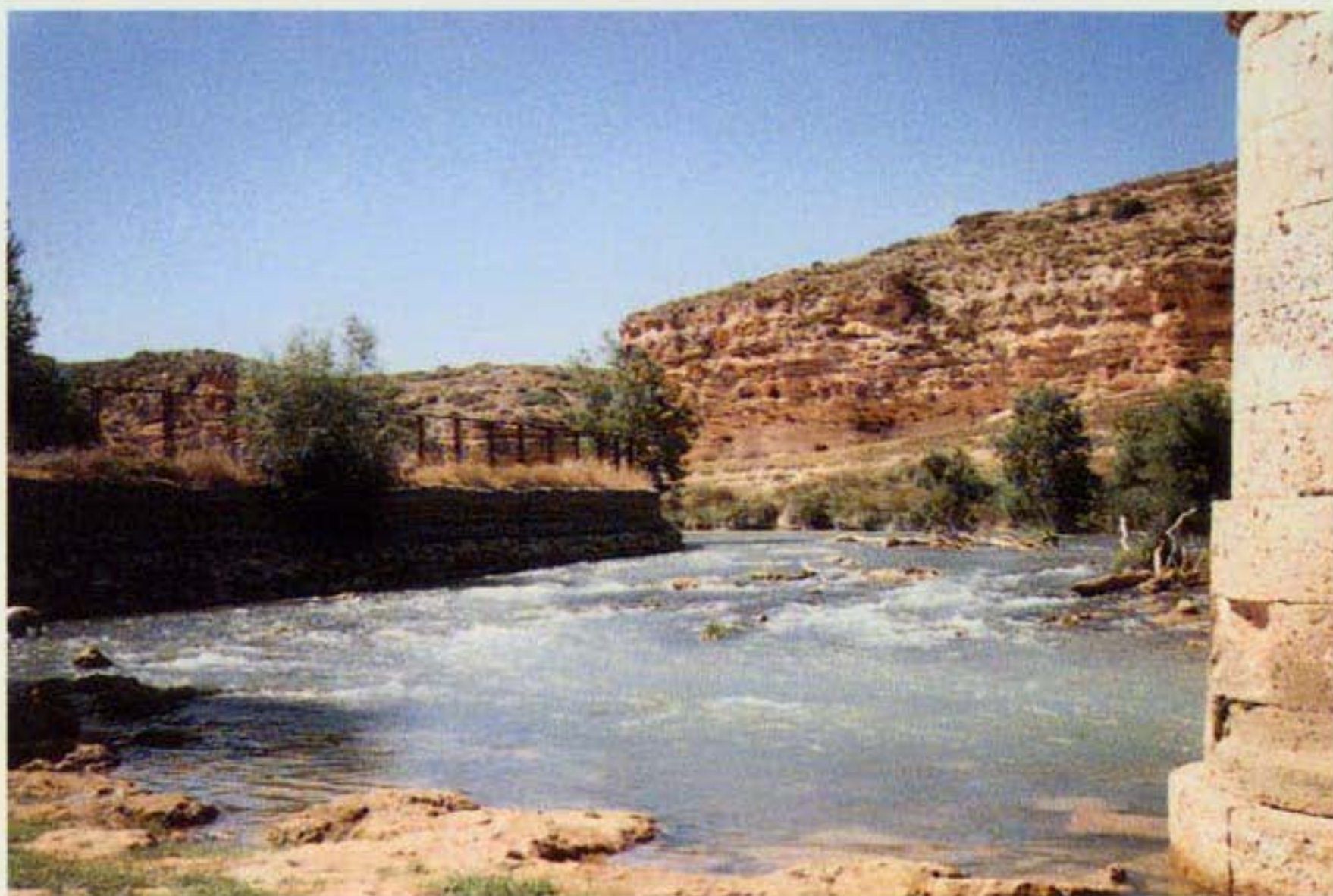
Estación J-4: Puente carretera de Motilleja.
