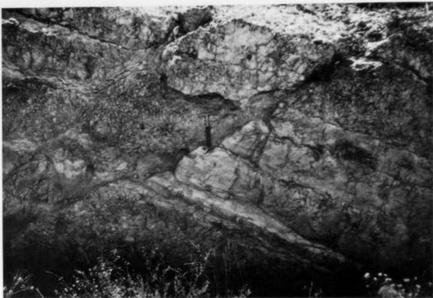
Foto n.º 3: Fallas en los flancos del anticlinal Cretácico de la parada n.º 2.
