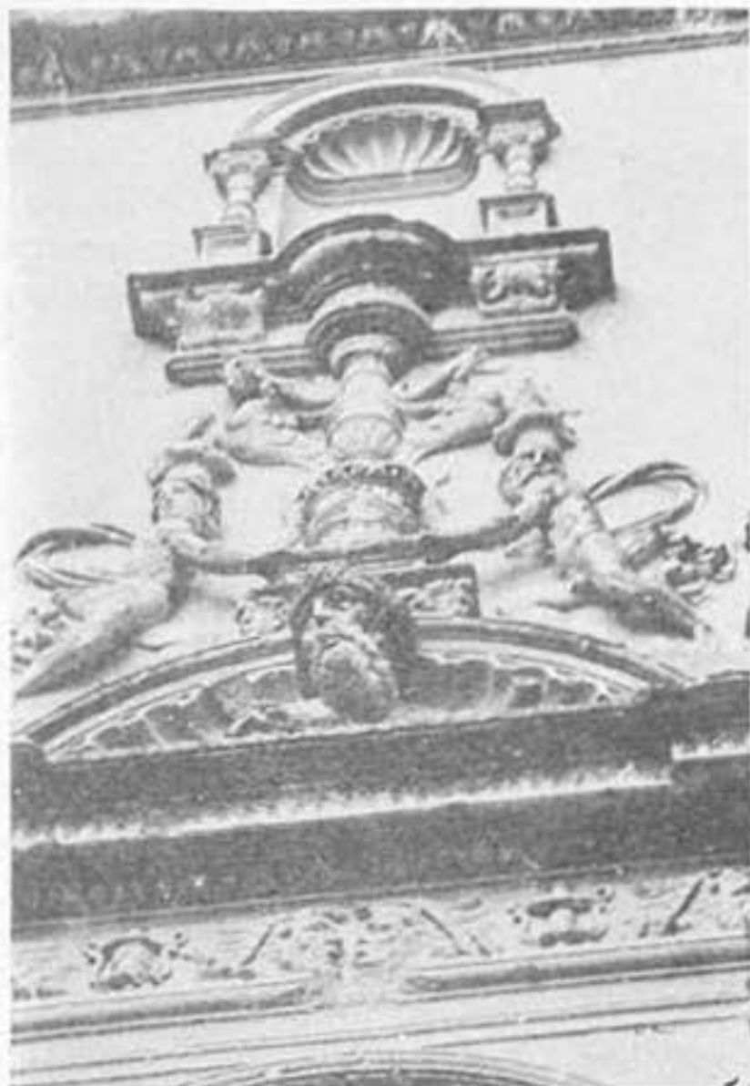
Fig. 7.- Santa María de Chinchilla. Exterior. Detalle del lienzo central del ábside.
