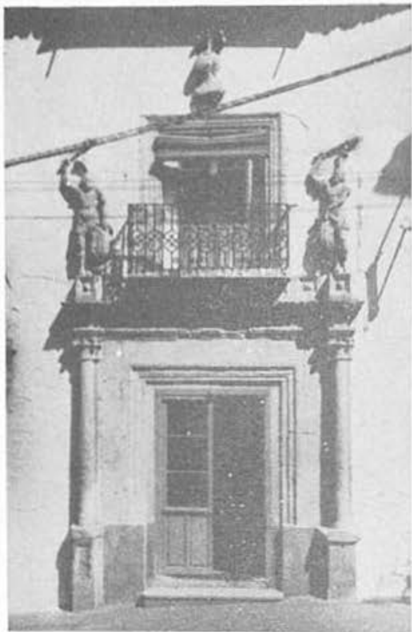
Fig. 15.- Antigua Casa de los Galianos. Alcaraz.
