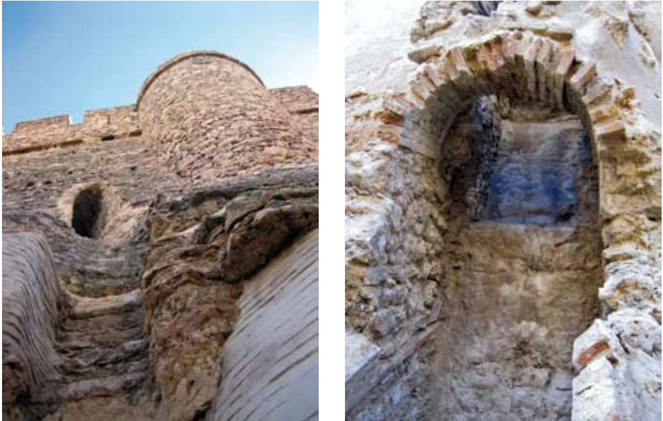
Fig. 6 y 7. Salida de la galería desde el lienzo del castillo (izquierda) y cubierta de ladrillo al atravesar el foso (derecha).
