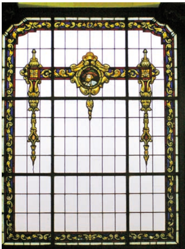
Fot. 14. La ornamentación se concentra en las cenefas que contornean cada uno de los ventanales y en los elementos clasicistas del cuerpo superior de los centrales. Domina el estilo neoplateresco, característico de todo el edificio
