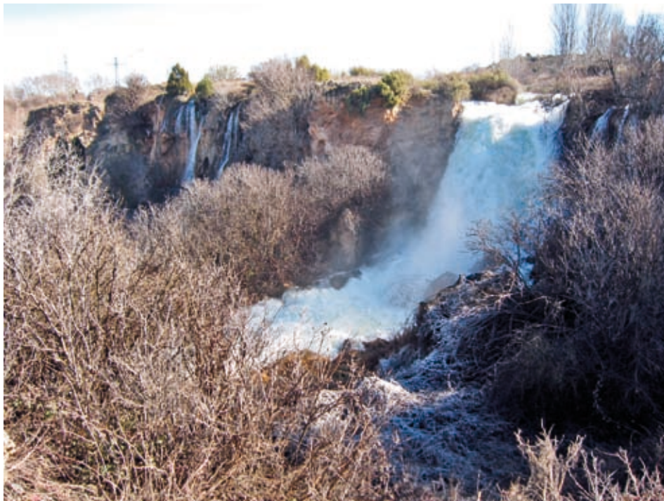
Fig. 3. Cascada de “El Hundimiento” cuyo salto se formó tras el colapso parcial de la barrera tobácea que represa las aguas de la Laguna del Rey vinculado a un episodio de avenida
