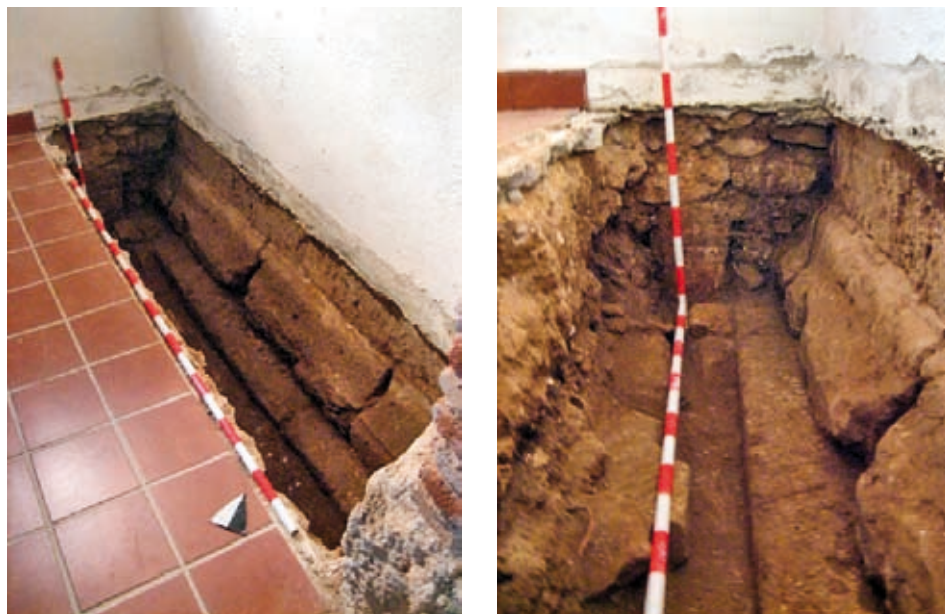
Fig. 11 y 12. Vista del basamento de la torre por la cara interna de la sacristía
