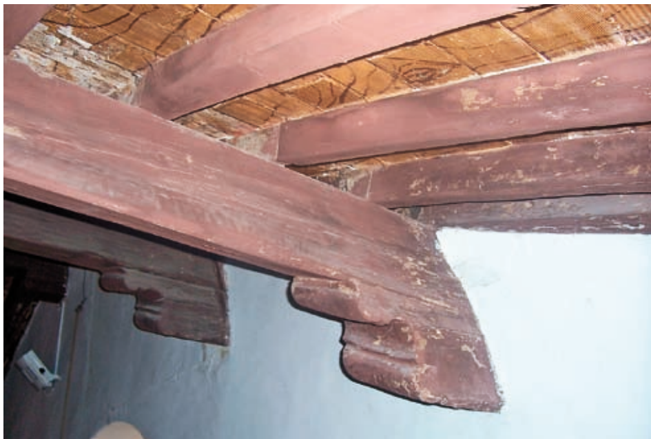
Fot. 4. Detalle de la cubierta
