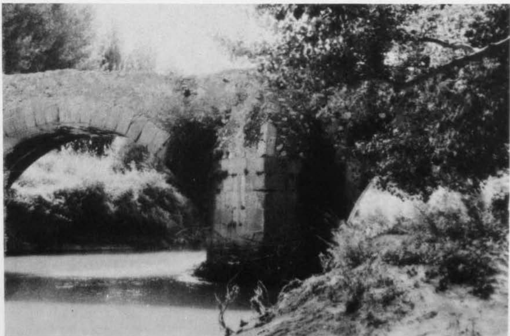
Puente número 1.- Vista desde aguas arriba.
