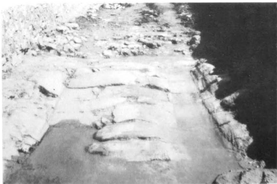
Puente número 1.- Vista de la calzada romana al tercer día de trabajo. Obsérvese el cambio de pavimento en la parte superior.
