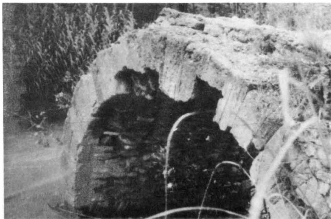
El puente número 2 visto desde aguas arriba. Obsérvese la diferencia entre la bóveda y el trasdos con las irregulares dovelas.
