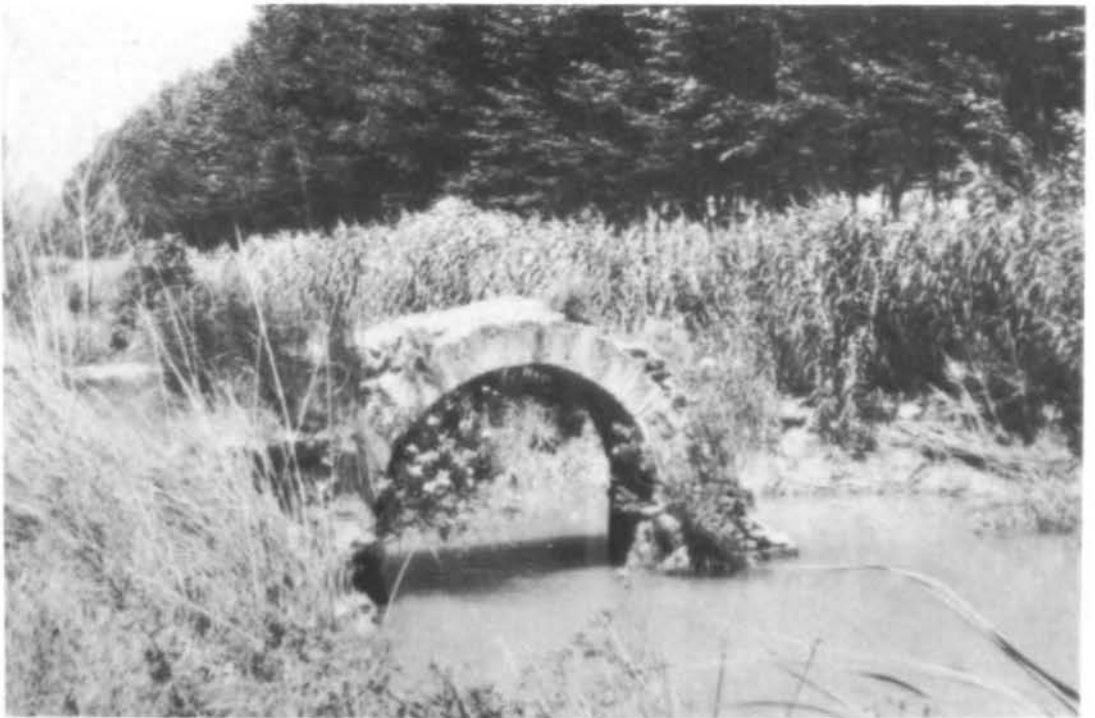
Puente número 2.- Detalle del firme de cemento y cantos rodados sobre el puente.
