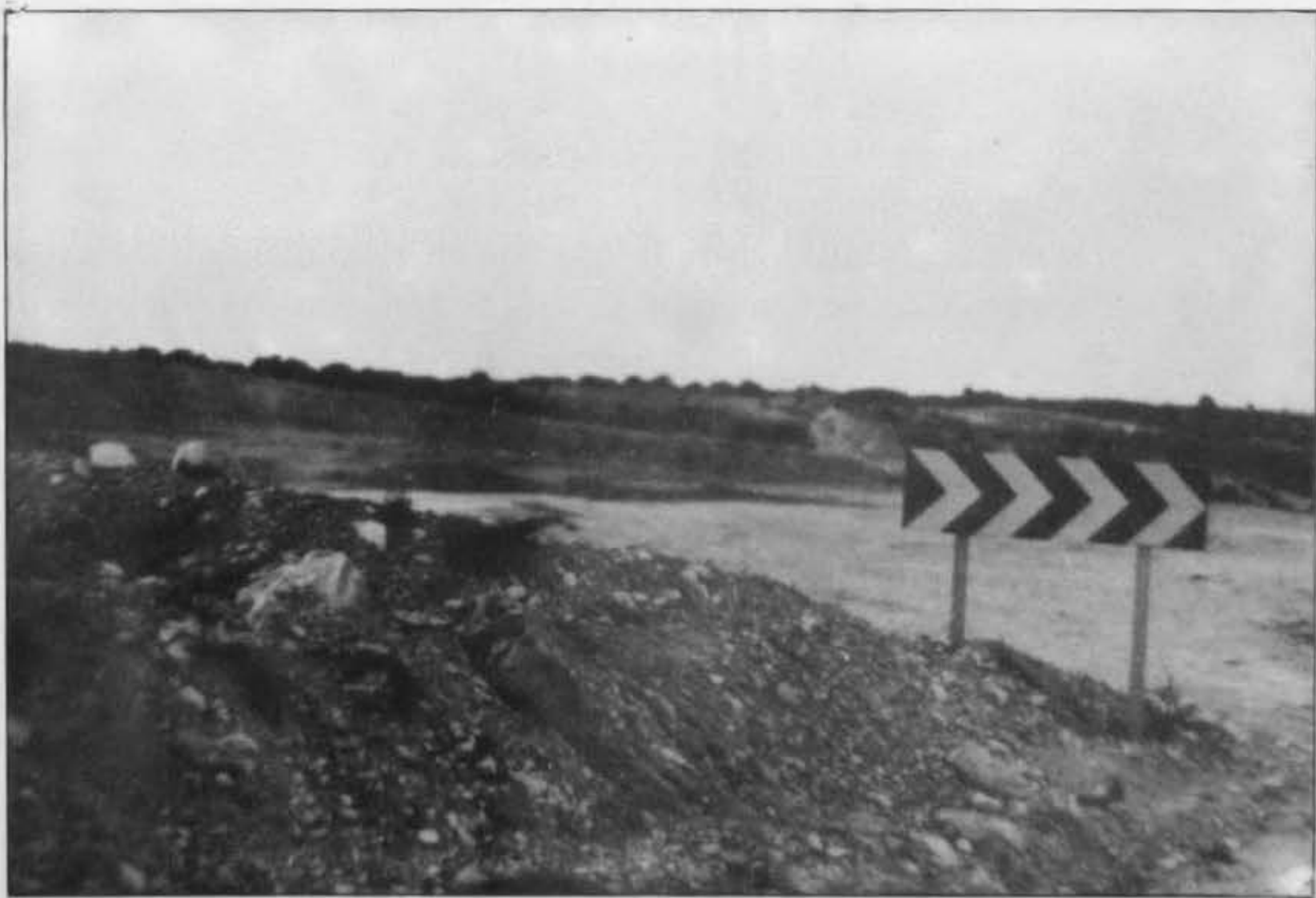
Foto 14.— IMPACTOS: Fuerte desmantelamiento y movimiento de tierras, producto de obras en la carretera nacional de Córdoba a Valencia a la altura del Valle del río Júcar que provoca una mayor erosión.
