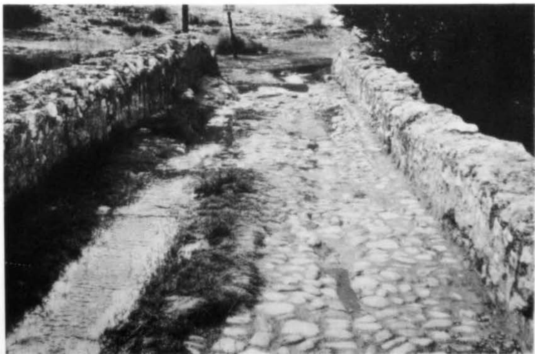
El pavimento de cantos rodados en primer término. Al fondo la calzada de losas en disposición horizontal.
