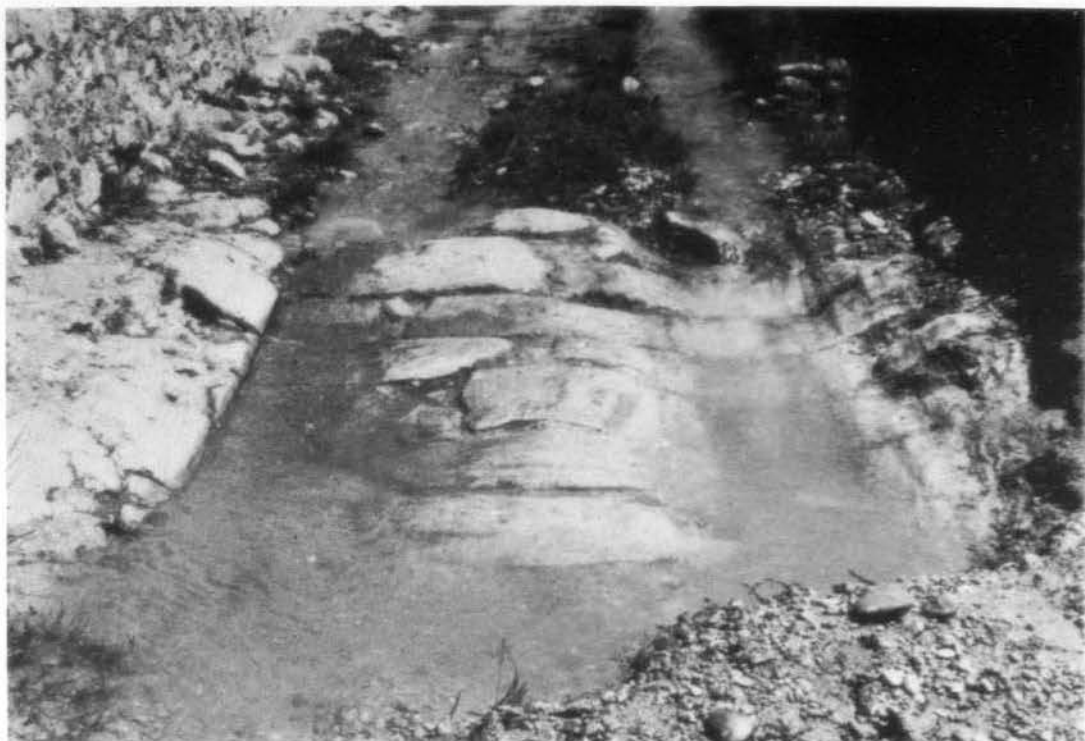
Puente número 1.- Vista de la calzada romana tras el segundo día de trabajo.
