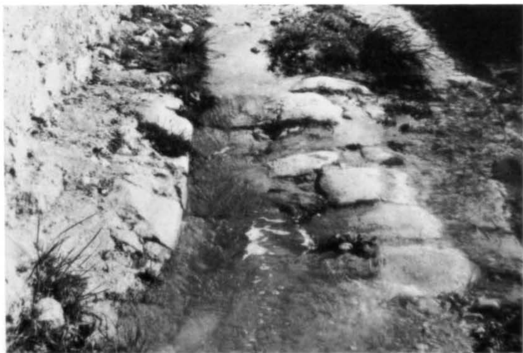
Puente número 1.- Vista de la calzada romana tras el primer día de trabajo.
