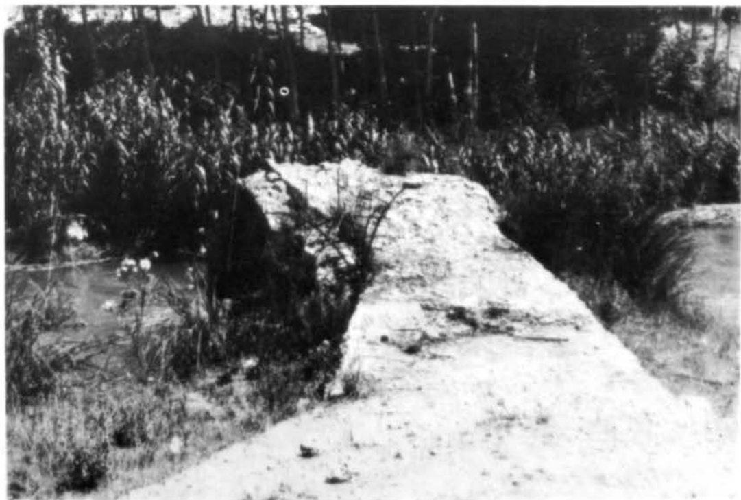
Puente número 2.- Vista Sur del puente. Obsérvese el camino formado por la argamasa y los cantos rodados. Se trata de una verdadera calzada.
