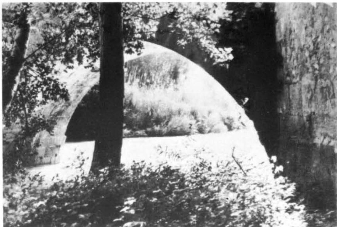
Puente número 1.- Vista del arco principal más meridional. (Aguas arriba)
