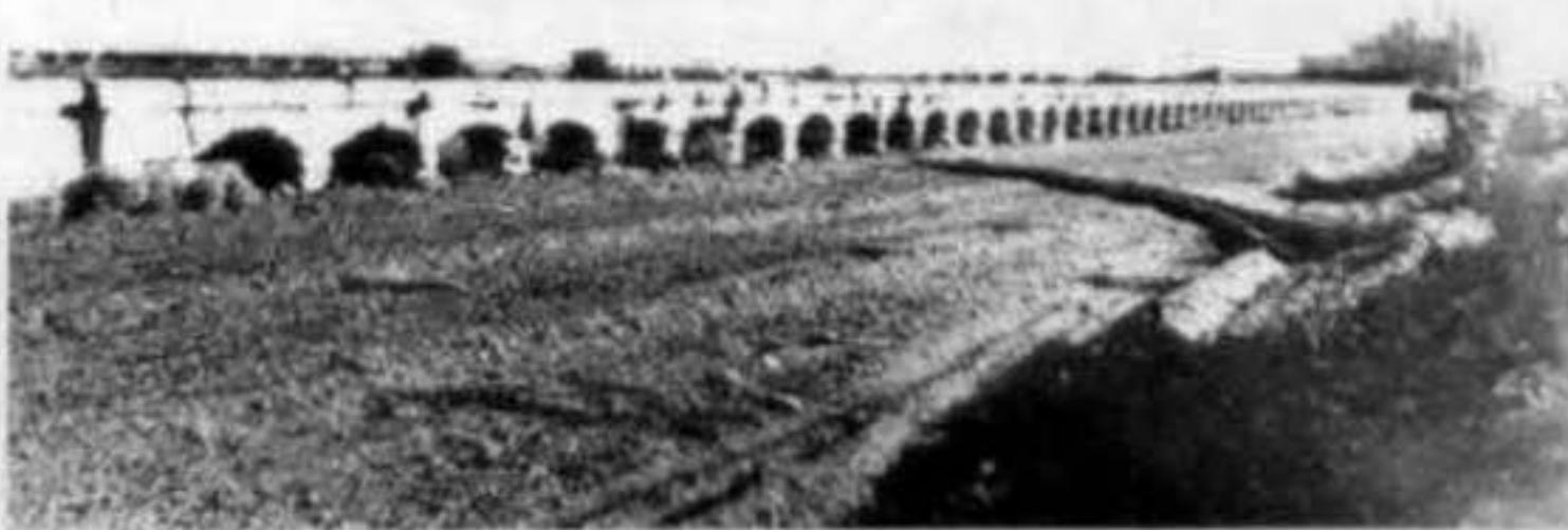
Vista parcial, desde el arranque del primer arco.
