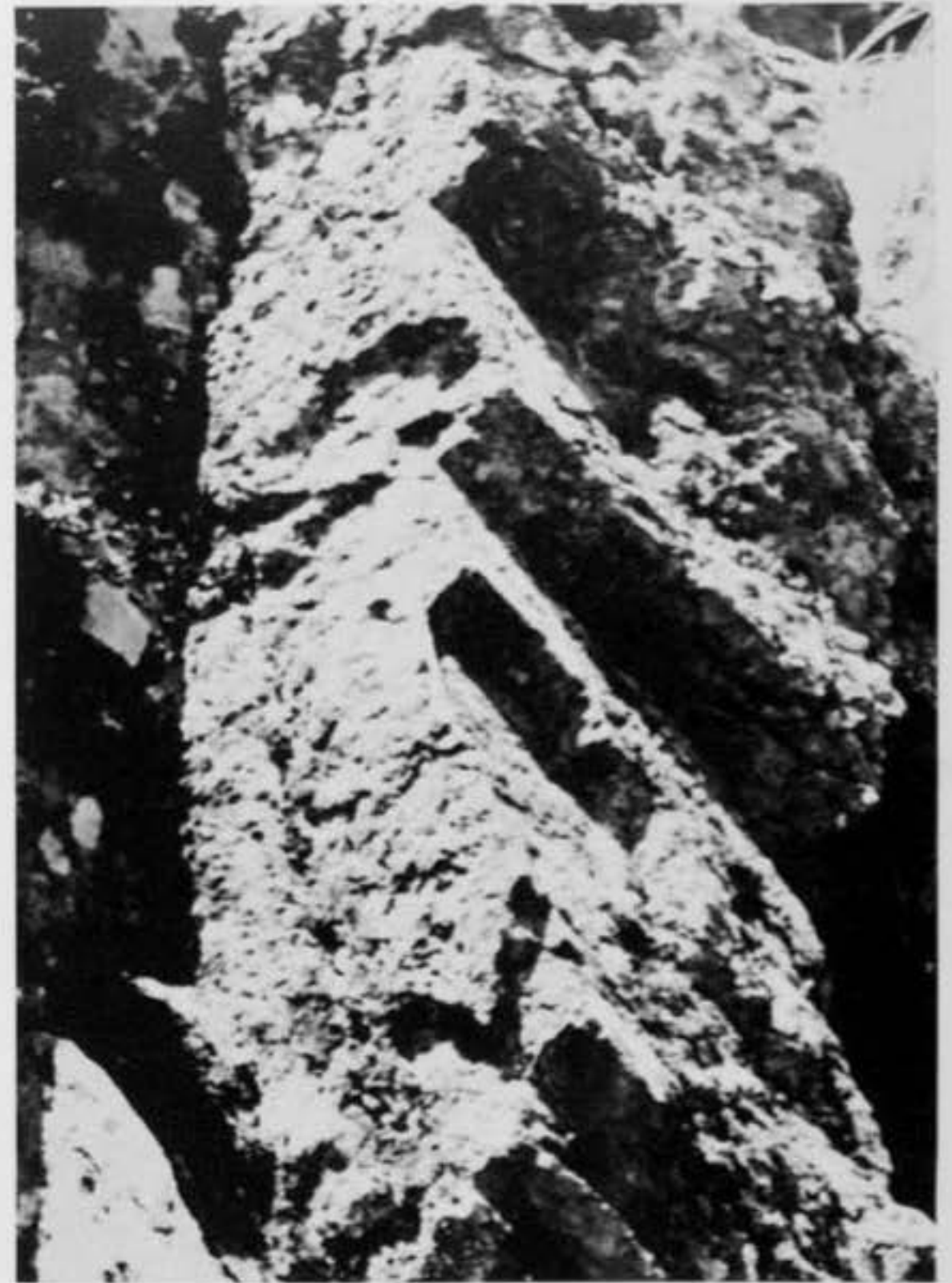
Foto n.º 22: Carretera de Bienservida a Albaladejo: Planos de diaclasa en las pizarras negras. Fotografía tomada a la misma altura que la fotografía n.º 21 pero en el margen izquierdo.
