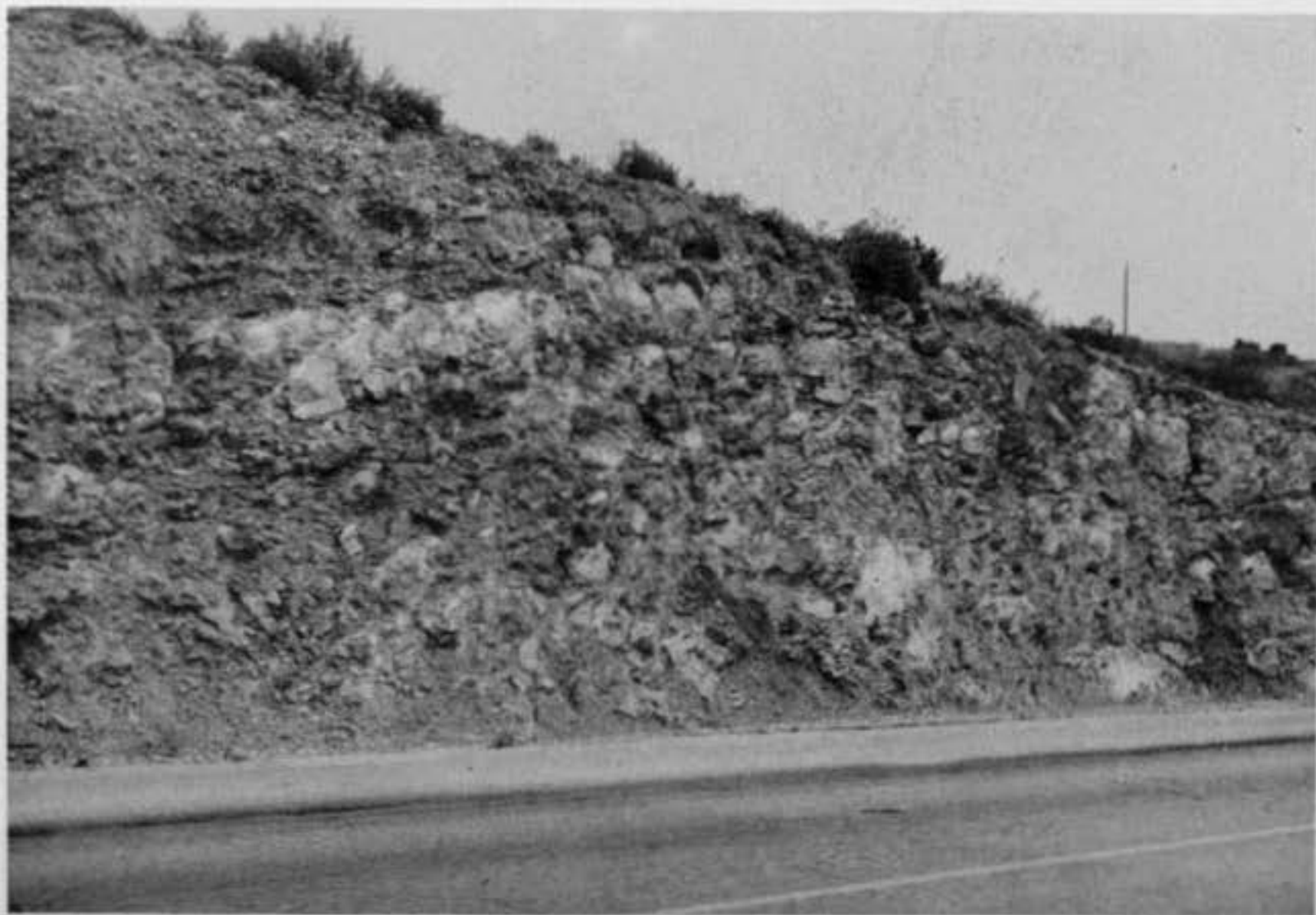
Foto n.º 2: Bloques y brechas calizas miocenas apoyadas sobre el relieve preexistente liásico.
