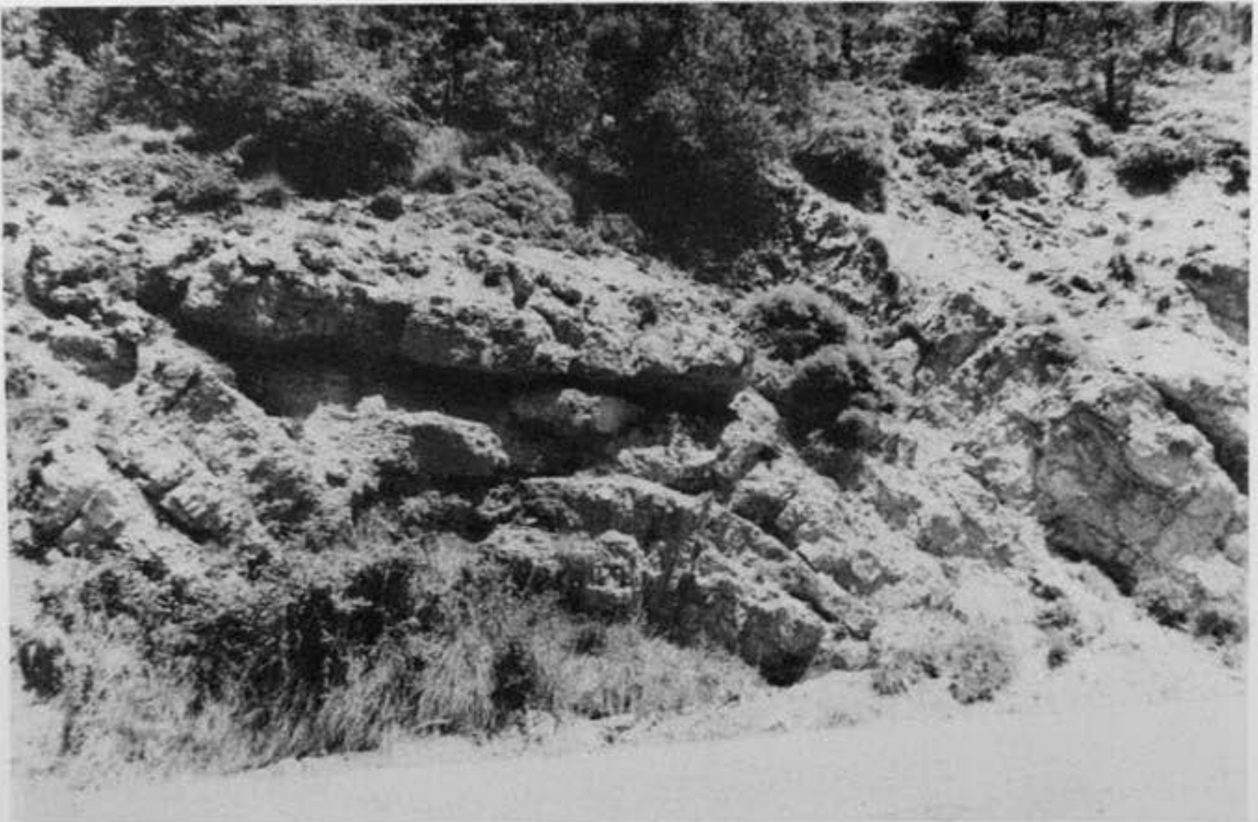
Foto n.º 31: Carretera de Vianos a Riópar: Pliegue-falla.
