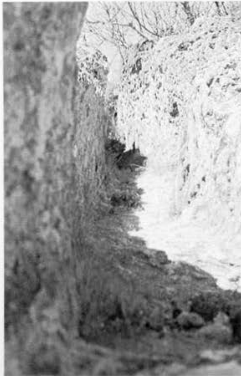
Fot. 9: Aliviadero excavado en la roca del batán anterior.
