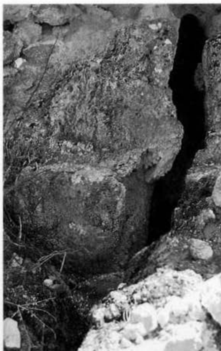
Fot. 5: Batán superior del derrame de la Tomilla. Abertura de despeñe del agua. Se puede apreciar la obra del declive necesario para que saliera el agua y no atascara la rueda.
