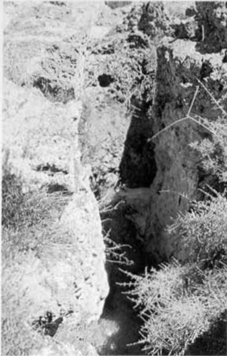
Fot. 6: Aliviadero excavado en la roca de uno de los batanes de la laguna Lengua.
