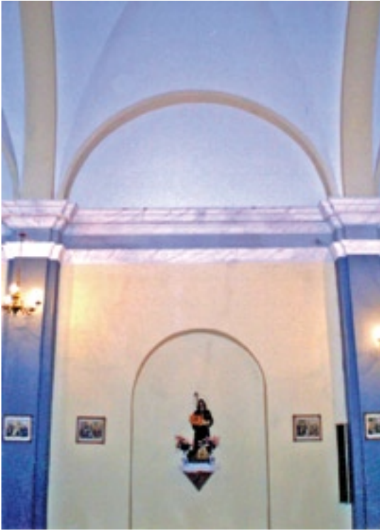
Fot. 2. Iglesia de San Pedro. Balsa de Ves. Interior. Detalle de dos de los pilares.
