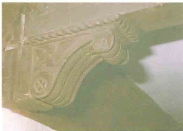
Fot. 15.- Ermita de la Inmaculada-San Blas. Tarazona de la Mancha. Ménsula de la armadura de madera. (Fot. Juan A. Picazo Monteagudo).
