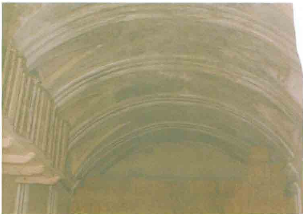
Fots. 29, 30 y 31.- Ermita de Buenavista. Buenavista (Tarazona de la Mancha). Detalles del interior y de las pinturas. (Fot. Juan A. Picazo Monteagudo).
