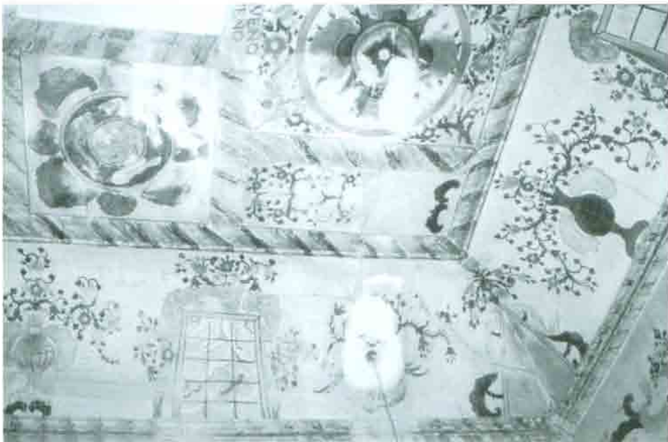
Fot. 10.- Ermita de San Roque. Tarazona de la Mancha. Detalle de las pinturas. (Fot. J. Sánchez Ferrer).
