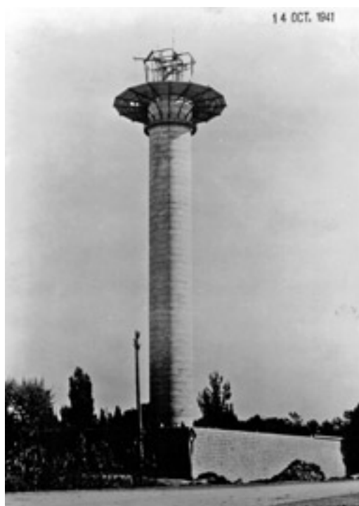
Imagen 18. Construcción de la chimenea (14-10-1941). AMAB, fotografía núm. 953.
