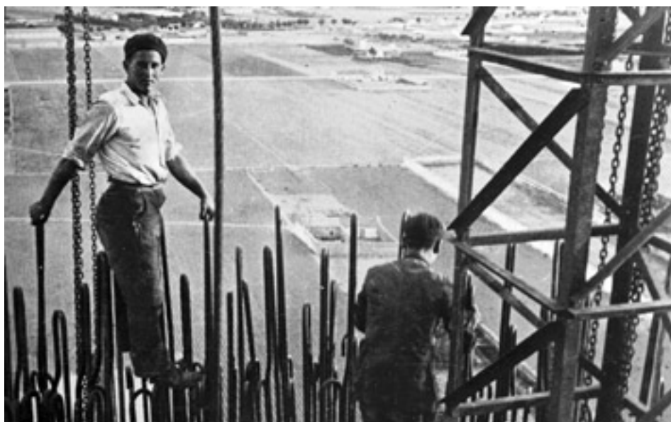
Imagen 17. Obreros sobre encofrado en chimenea. AMAB, foto núm. 963.
