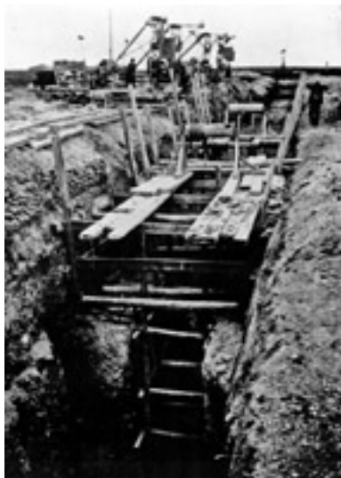
Imagen 7. Zanja de las obras de CAPTACION. AMAB, Fotografía s/núm.
