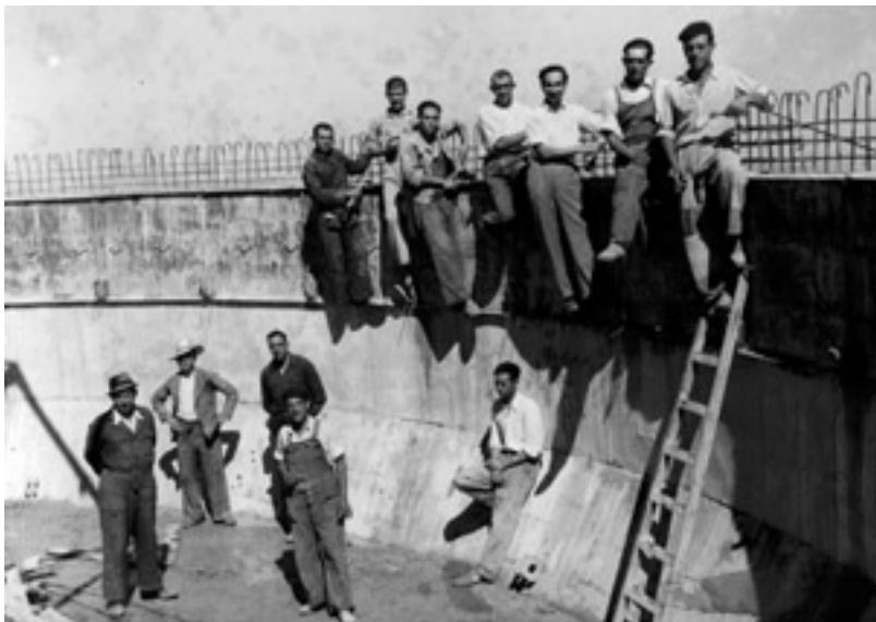
Imagen 19. Obreros en depósito elevado. AMAB, foto núm. 1042.
