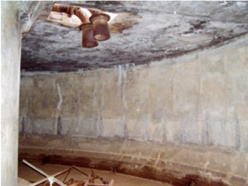
Imagen 22. Interior depósito elevado (2007) Foto Antonio Caulín.
