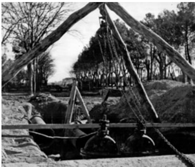
Imagen 28. Instalación de tuberías en paseo (14-12-1942). AMAB, fotografía núm. 988.
