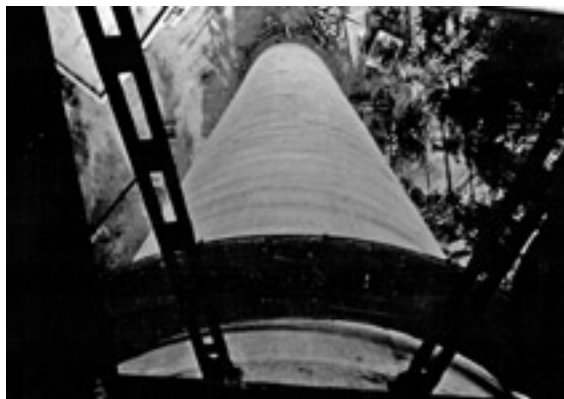
Imagen 20 Vista desde el suelo del depósito elevado. AMAB, foto núm. 962.
