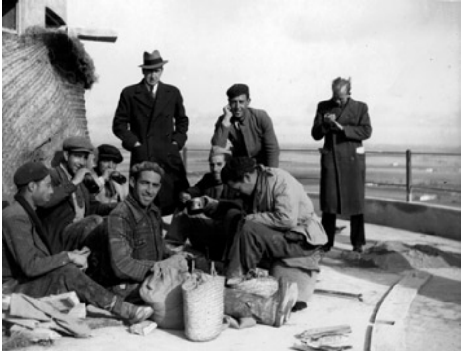
Imagen 21. Obreros sobre el depósito elevado. AMAB, fotografía núm. 1036.
