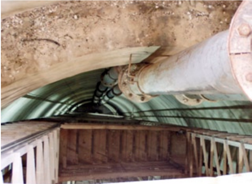
Imagen 23. Tubería interior de chimenea (2007). Foto Antonio Caulín.
