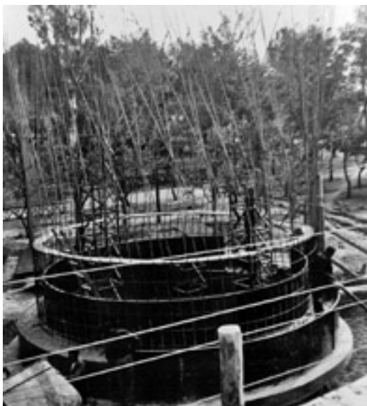
Imagen 13. Inicio forjado chimenea. AMAB, fotografía núm. 938.
