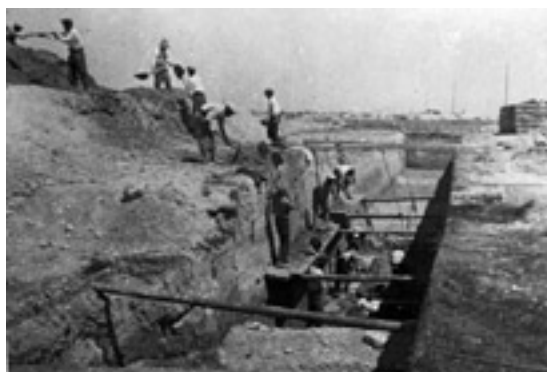
Imagen 8. Obras de conducción. AMAB, fotografía núm. 955.
