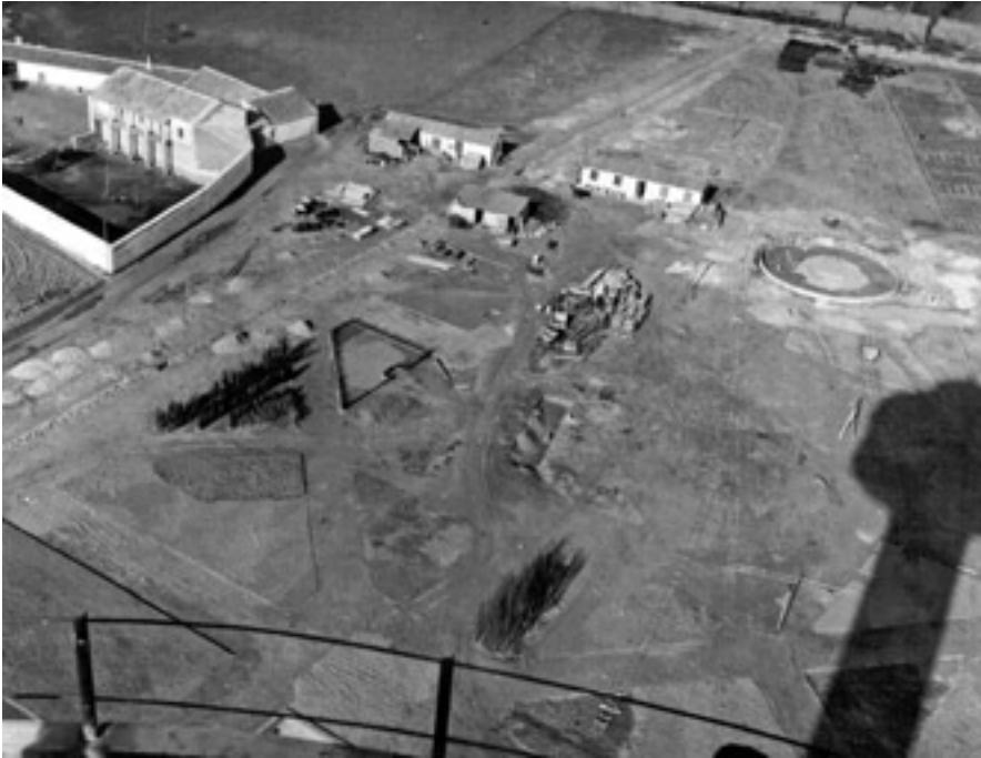
Imagen 14. Construcción jardines (aprox 1942). AMAB, foto núm. 974.
