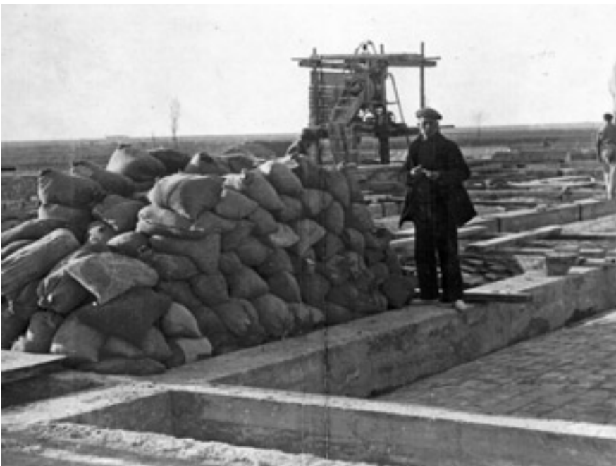
Imagen 15. Sobre el encofrado del depósito de almacenaje. AMAB, foto núm. 954.
