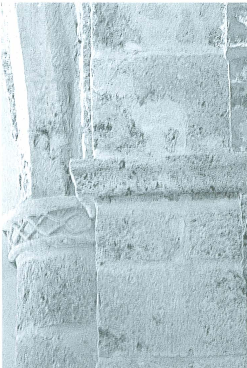
Fot. 9. Ermita. Capitel de uno de los pilares del primer arco diafragma.
