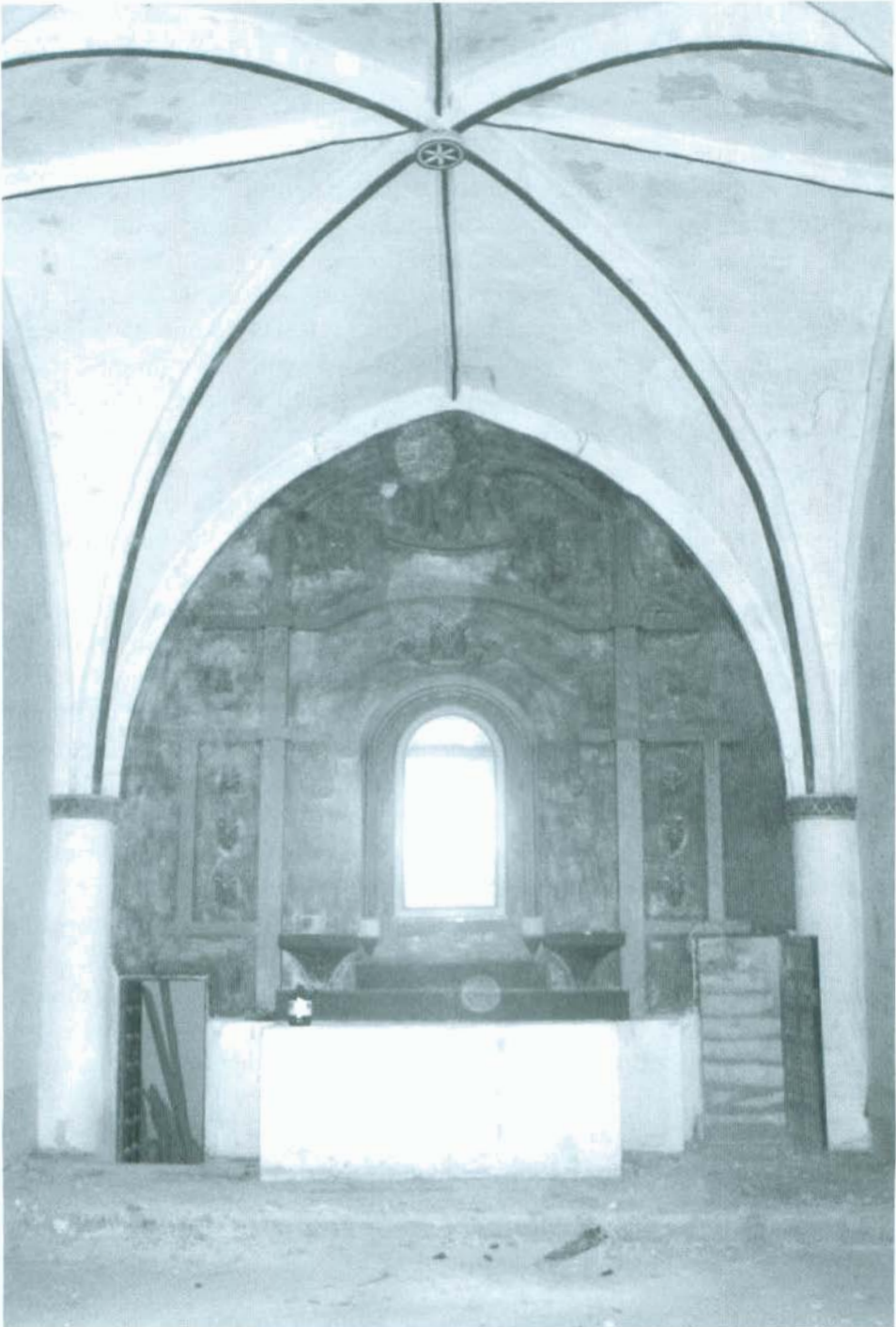
Fot. 21. Ermita. Aspecto del presbiterio antes de comenzar la restauración.
