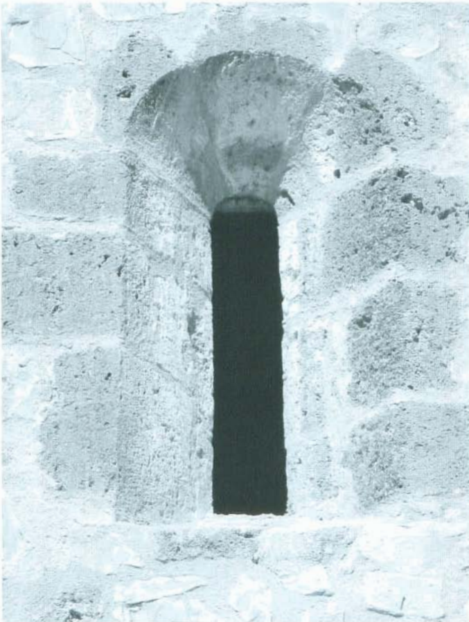
Fot. 18. Ermita. Exterior del presbiterio. Ventana abocinada.
