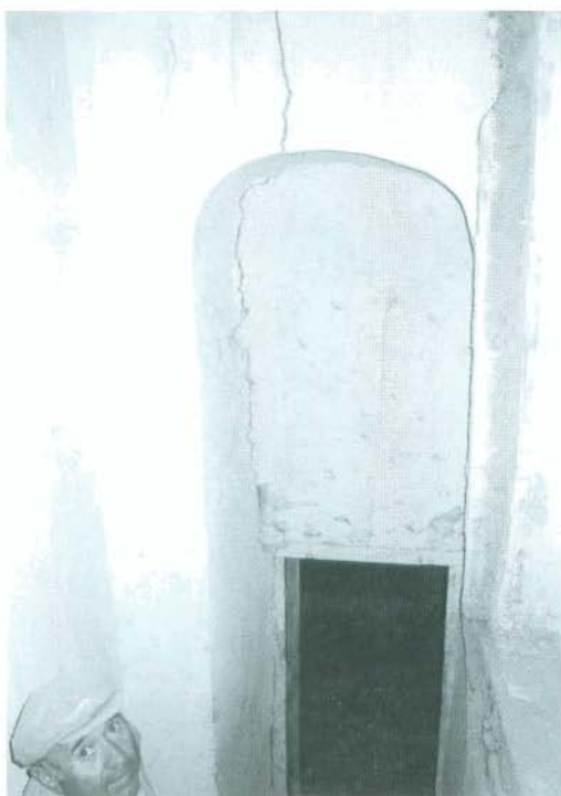
Fot. 33. Ermita. Vano de la puerta del camarín cuando éste se construyó, luego fue tapiada su parte superior.
