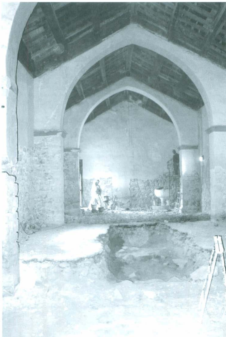
Fot. 24. Ermita. Detalle de la excavación.
