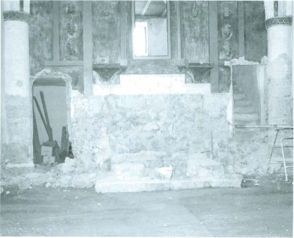
Fot. 28. Ermita. Puertas de la sacristía y del camarín tras la desaparición del relleno. El vano de la sacristía ya aparece abierto hasta el suelo primitivo del presbiterio y de la sacristía. En primer término la base del altar anterior al relleno.
