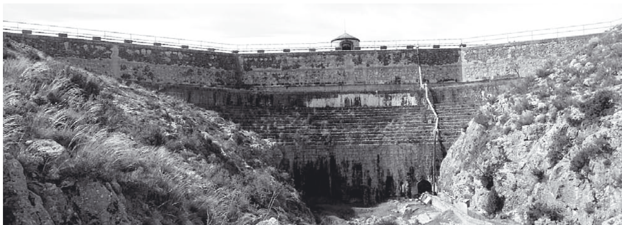
5. Presa del pantano de Almansa. El cuerpo inferior abovedado fue construido entre 1584 y 1586; el recrecimiento superior, diseñado por Rivelles, en 1788. Fotografía: M. J. Pereda Hernández.
