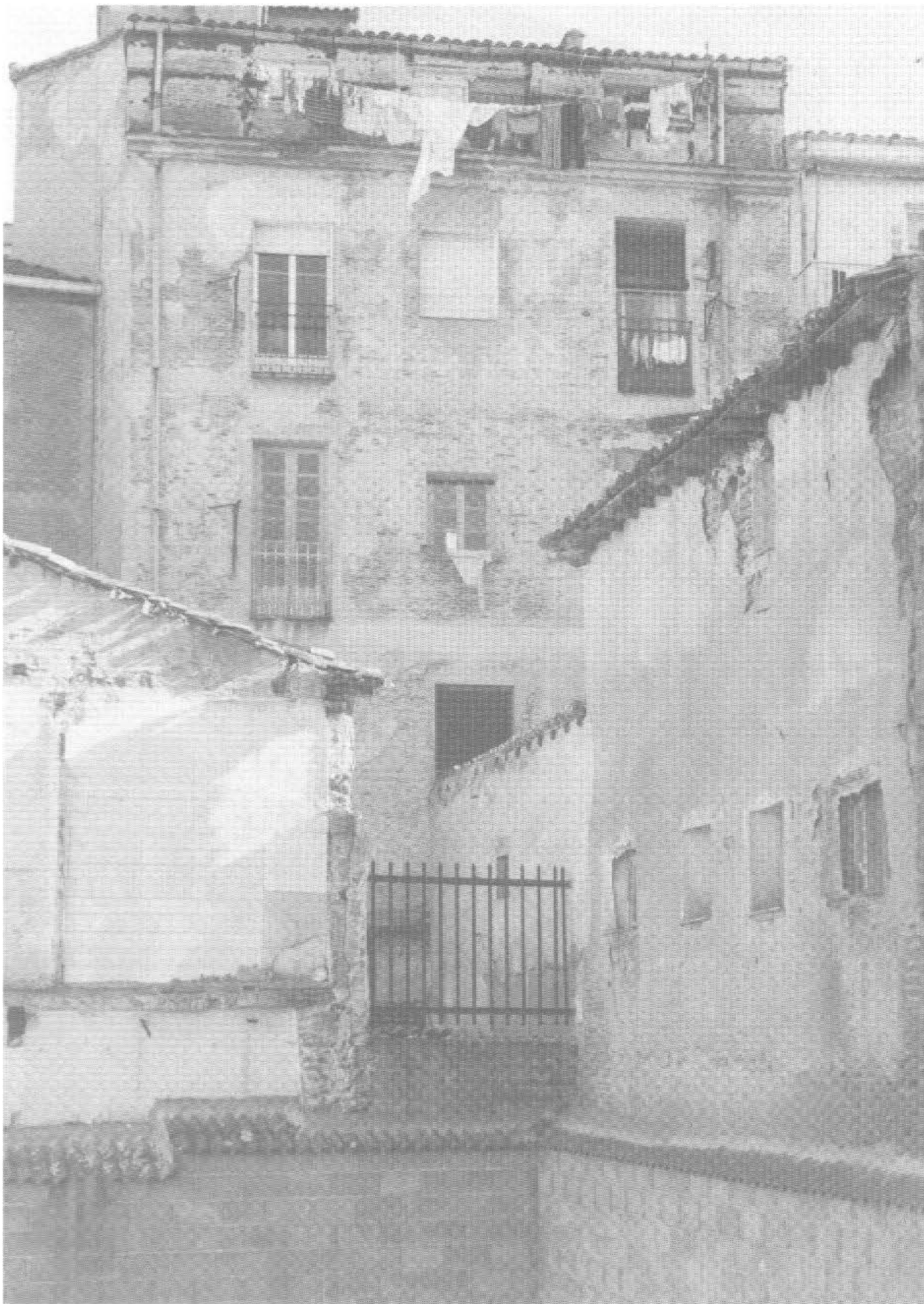
Callejuela de San Juan de Dios. Enajenada definitivamente en 1906; las transformaciones en las fincas colindantes han desfigurado su traslado, perpendicular a la calle Miguel Fluiters, a la que ha quedado cerrada por la edificación del fondo de nuestra fotografía.
