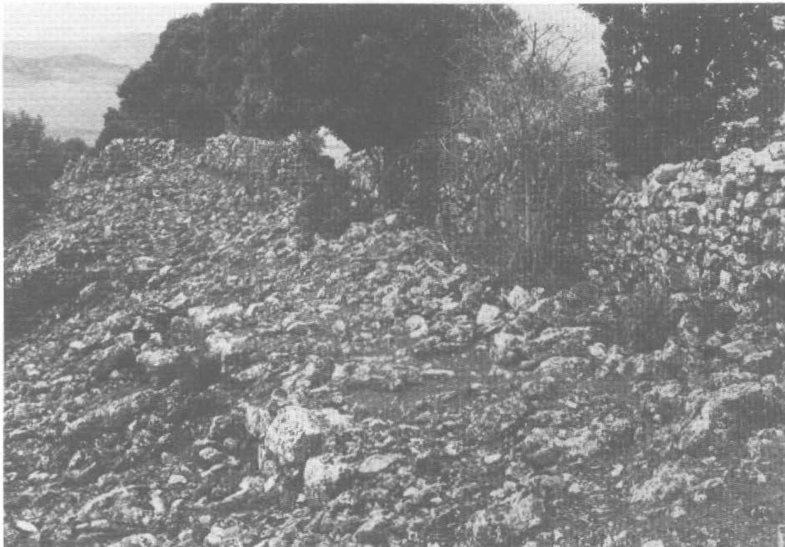
a) Base de la línea de muralla y derrumbe.
