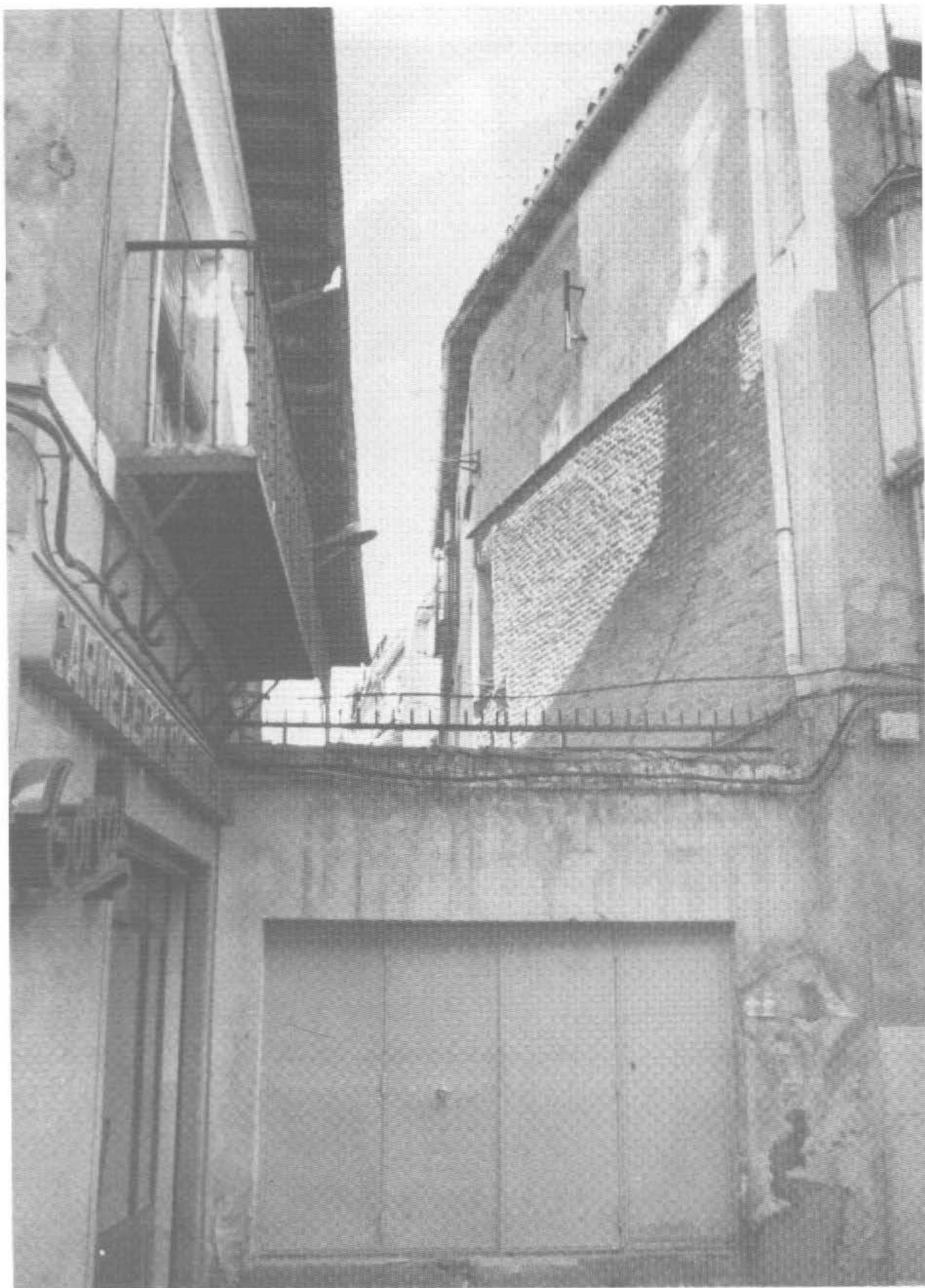
Callejuela de la Cruz Verde o de Hurones. Esta puerta de la calle Román Atienza cierra el acceso a la antigua callejuela, a la que tienen fachada posterior las edificaciones de la calle Mayor.
