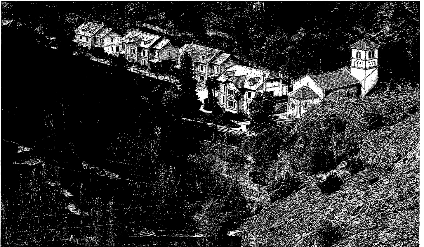
Central Hidroeléctrica de Villalba (Cuenca).
