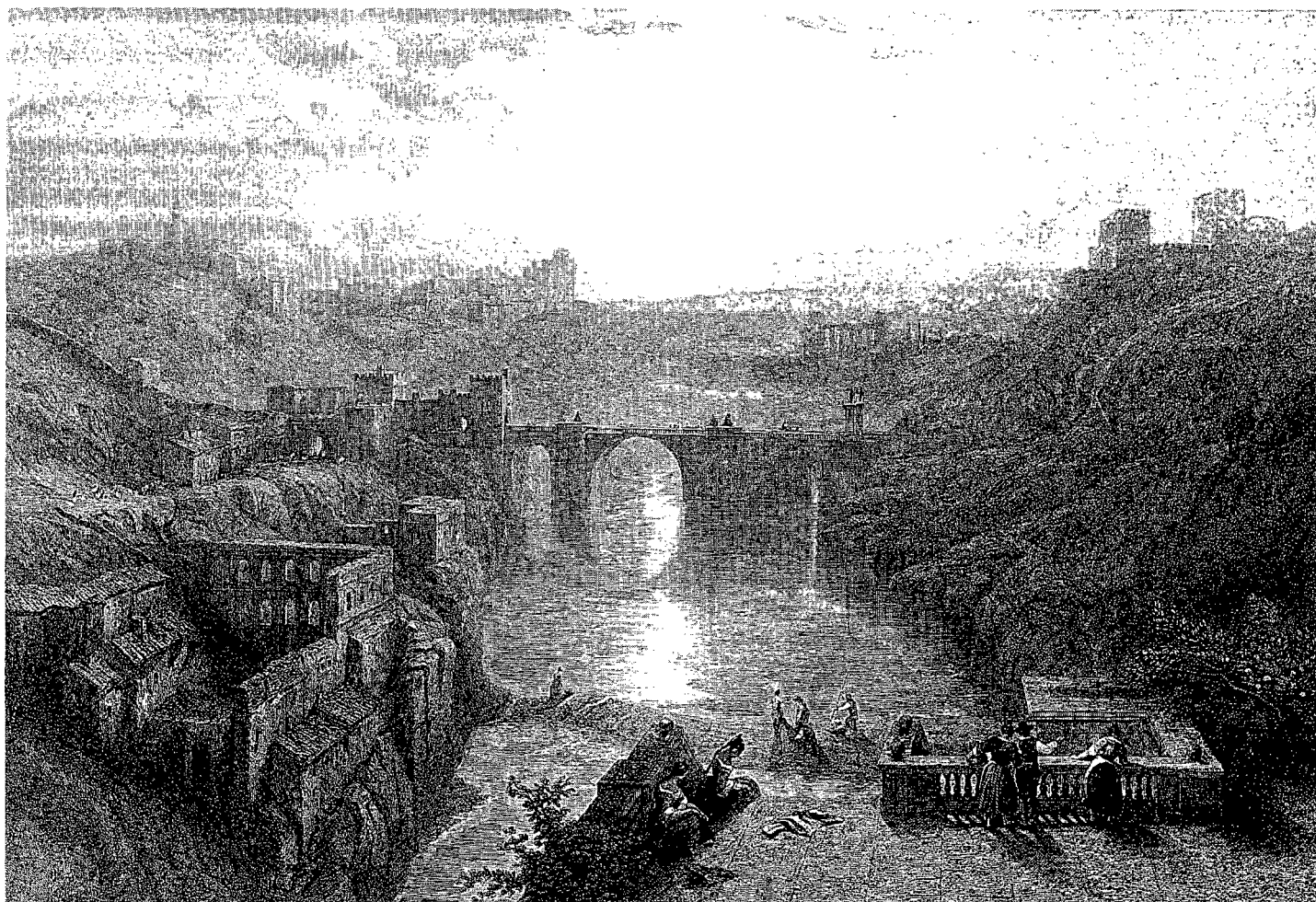
El puente de Toledo. Grabado de David Robert, en Royal Gallery of Art, 1854.
