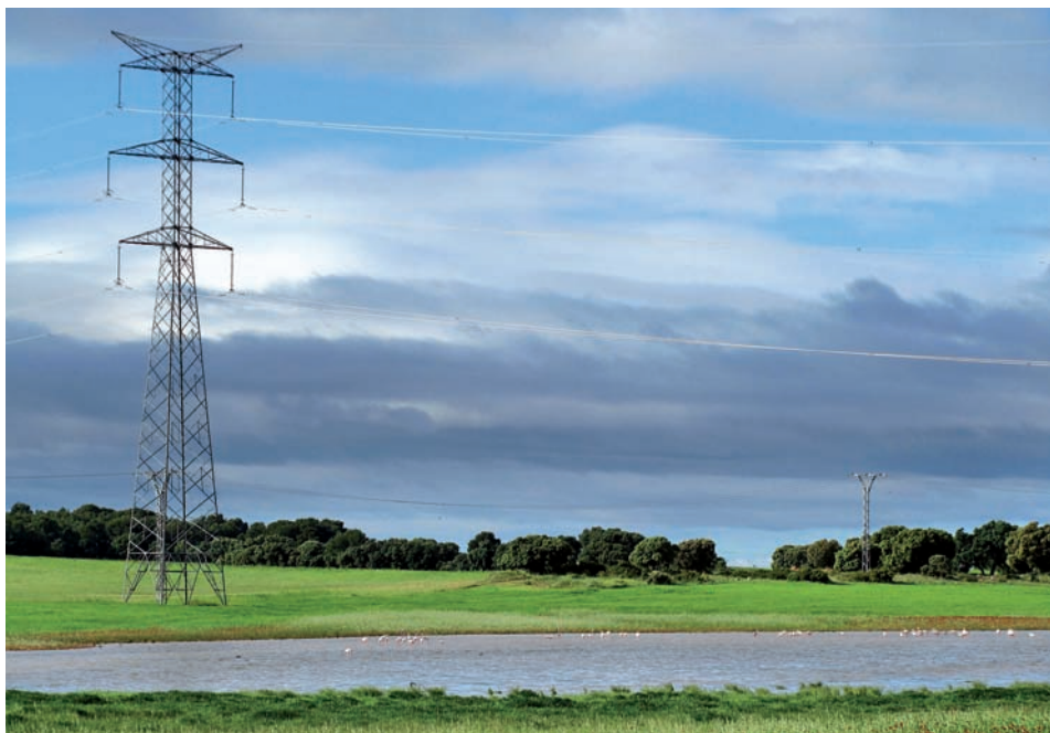
Foto 1. Tendido eléctrico de transporte que atraviesa la Laguna de Casa Palomera (Chinchilla de Montearagón, Albacete). En el humedal, varios grupos de flamencos comunes. Foto. Juan Picazo.
