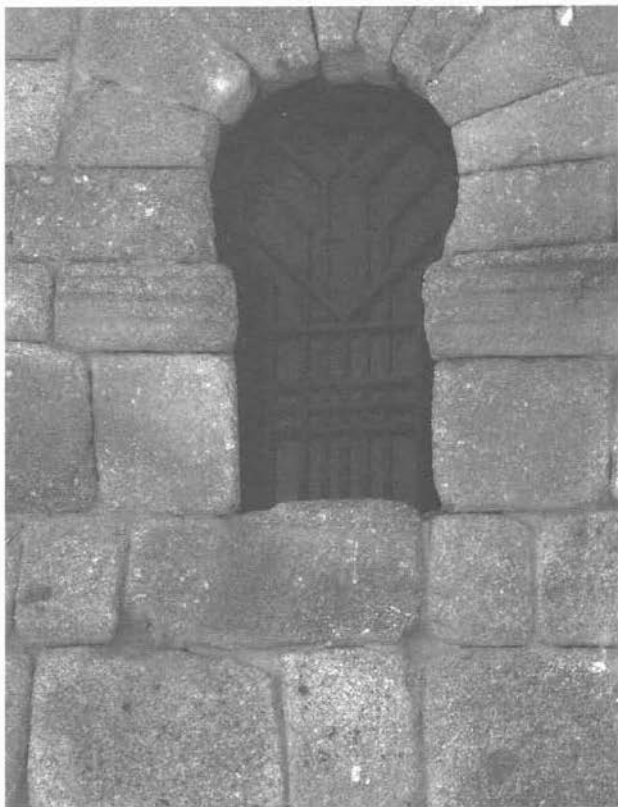
Fotografía VIII.- Detalle del cerramiento actual de las ventanas del edificio. Previsiblemente esta necesidad nació vinculada a la seguridad actual contra posibles robos, cambiando el diseño por el afán creador de los segundos arquitectos restauradores, cuyo gusto estético se impuso sobre el de Menéndez Pidal.
