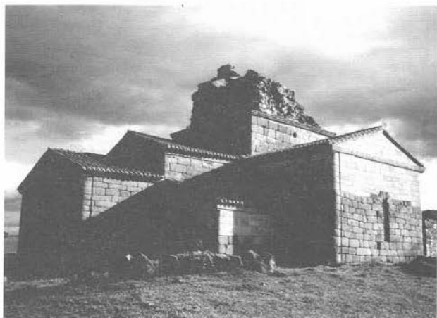
Fotografía I.- La fotografía más antigua que conservo en mi archivo, de Santa María de Montalbán no la tengo fechada, siendo posterior a la restauración de José Hernández Pidal, cuya sillería nueva se distingue perfectamente de la antigua y anterior a los trabajos de Luis Caballero Zoreda.
