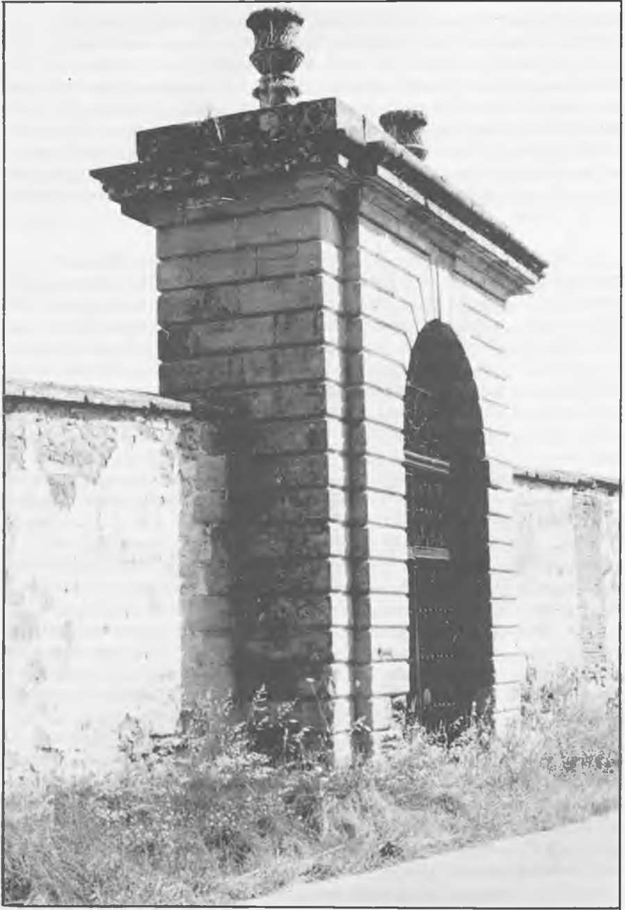
Puerta Sur neoclásica de la Obra del Obispo, junto a su fuente de la carretera de Alcuneza.
