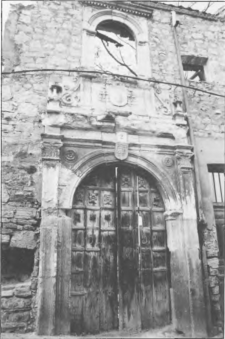
Ensanche. Calle de la Yedra. Restos del posible Palacio de D. Fadrique de Portugal
