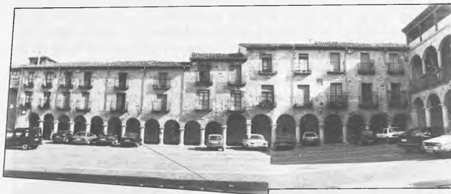
Fig. 8. Arcadas de la primera intervención en la Plaza de la Iglesia y de su ensanchamiento.
