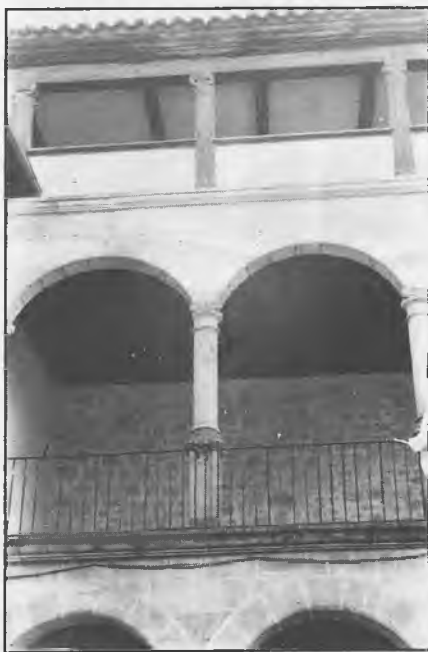
Fig. 11. Detalle de las galerías de la casa principal de la Obra, actual Ayuntamiento.
