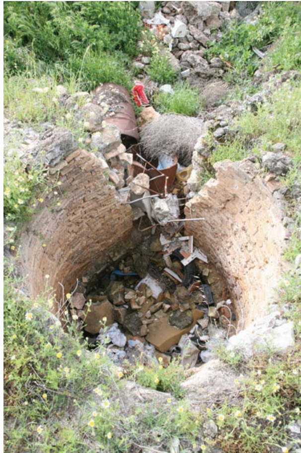
Vista de una calera antes de intervenir.
