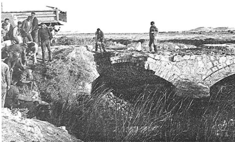
Este es el aspecto que presentaba el puente de San Juan, situado en el camino vecinal de Dosbarrios a la Estación de El Casar de la Guardia, antes de su reparación
