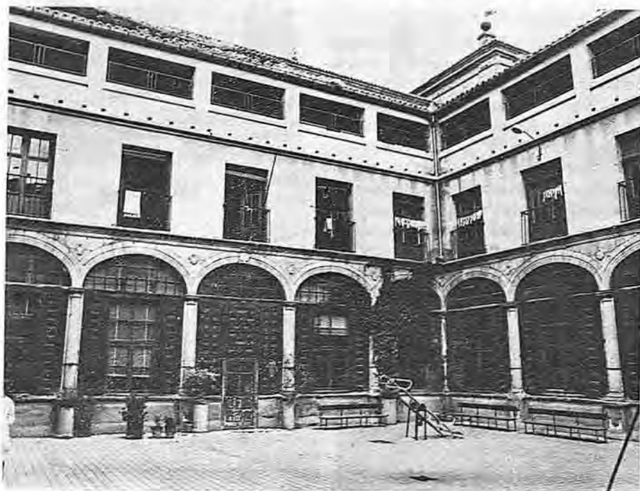
Claustro de los Naranjos
