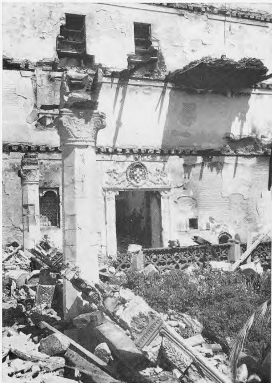
Lámina 50 Estado en que quedó el claustro después del incendio de 1936
