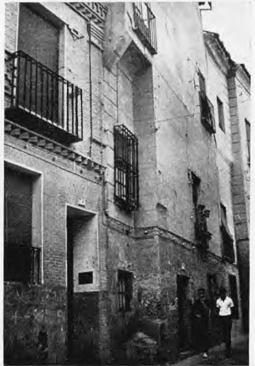
LÁMINA XVI.—Calles muertas de Toledo.—Antigua salida del callejón del Abogado, entre los núms. 7 y 9 de la bajada a los Carmelitas Descalzos, absorbido por una colindante, quizá por tener un cobertizo sobre él.
