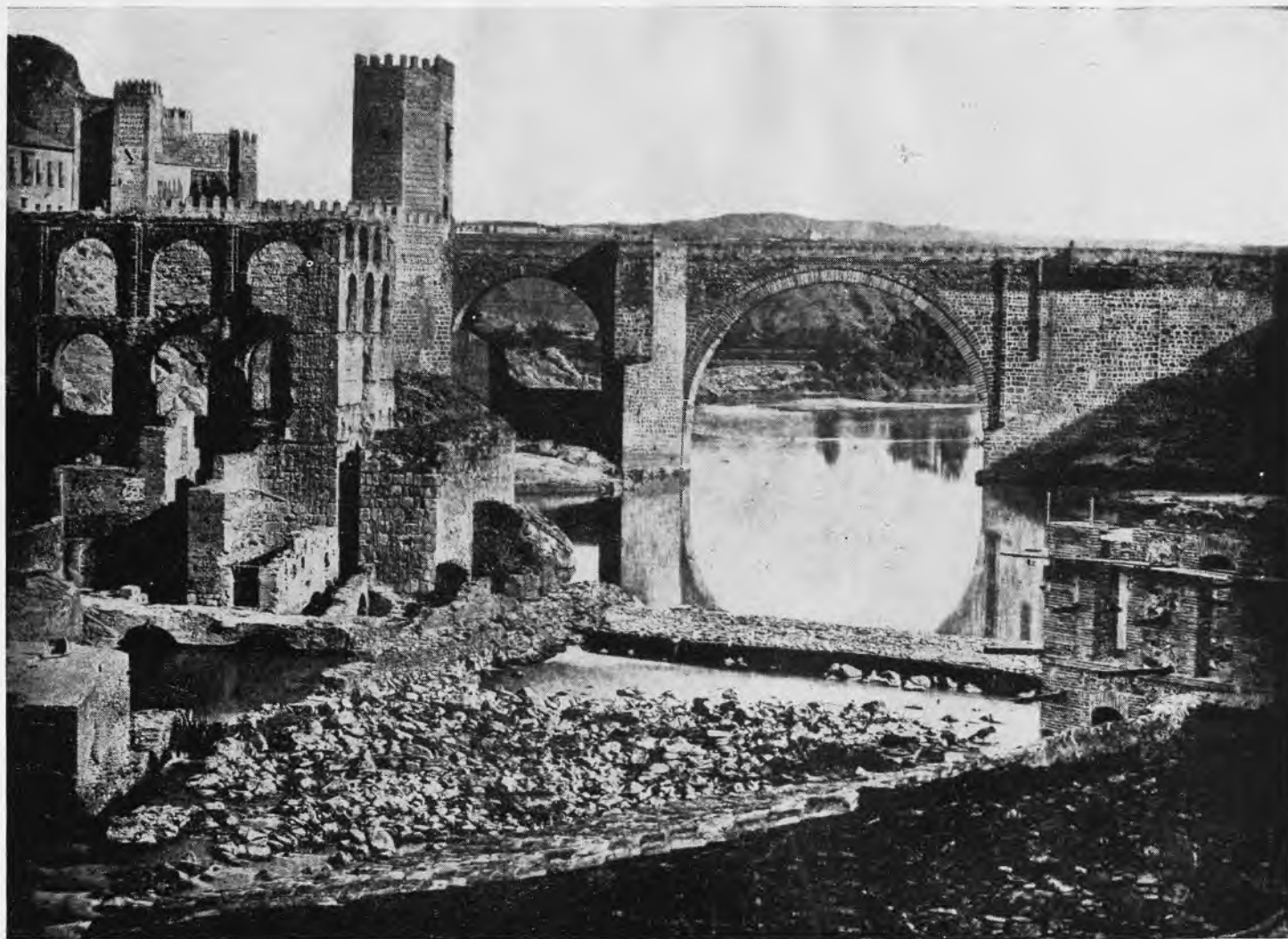
LÁMINA I.—Puente de Alcántara en 1867, con la «cadena de cucharas» en que comenzaba el Artificio de Juanelo y la puerta de San Ildefonso, demolida en 1870.
