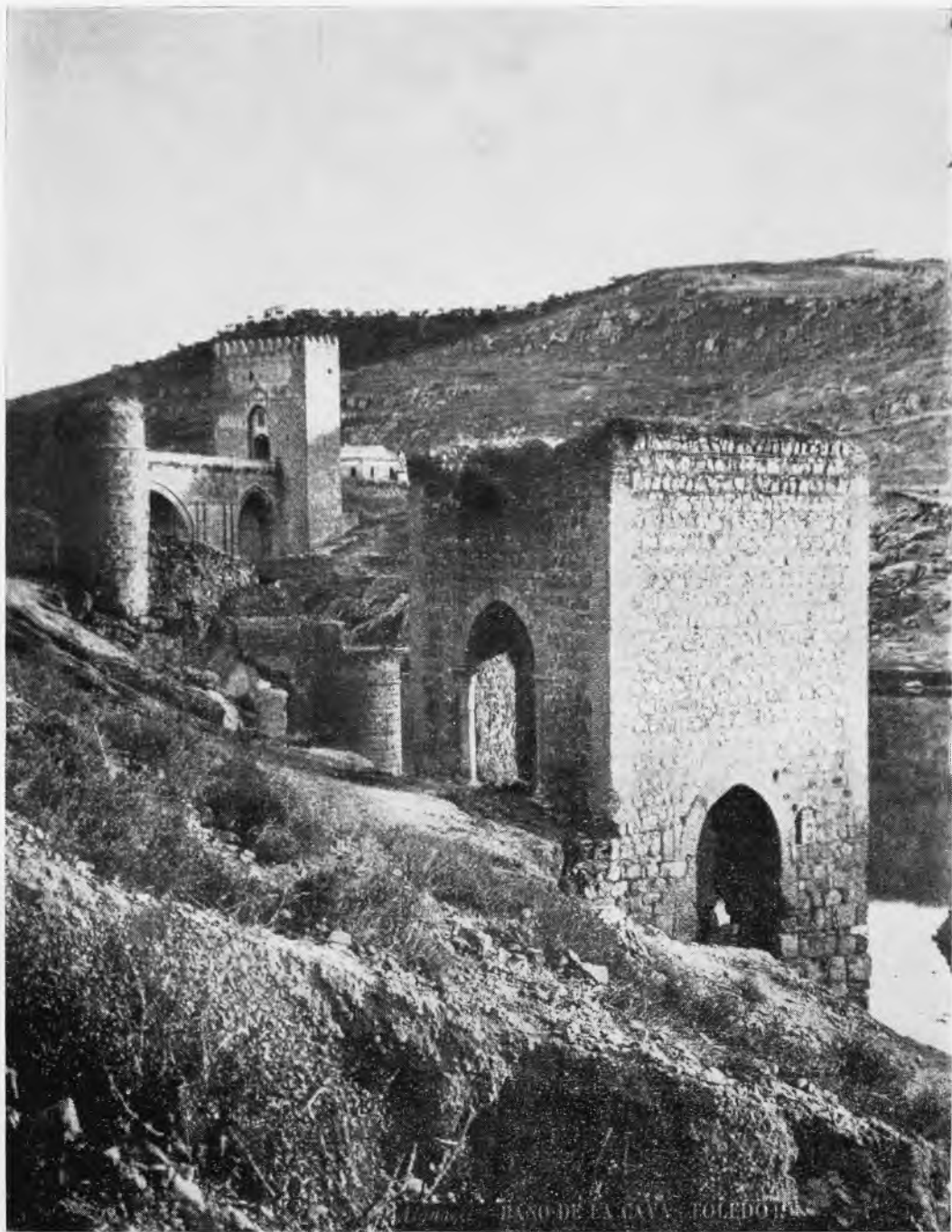
LÁMINA XII.—El llamado «Baño de la Cava» a fines de siglo, según una vieja fotografía de Alguacil. Obsérvese la muy distinta altura de las dos puertas de entrada, necesaria por el nivel variable del puente de barcas.
