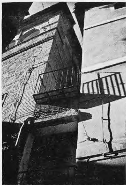
LÁMINA XIII.—Calles muertas de Toledo.—Casa núm. 5 de la calle de la Plata, de dos plantas, construida sobre un callejón suprimido.
