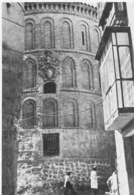
23. SAN VICENTE. Vista frontal del exterior.
