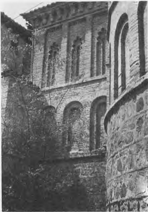
21. SAN BARTOLOMÉ. Exterior del ábside, Lado de la epístola.
