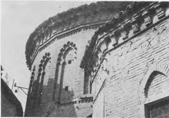
19. SAN JUSTO. Parte superior del exterior del ábside.
