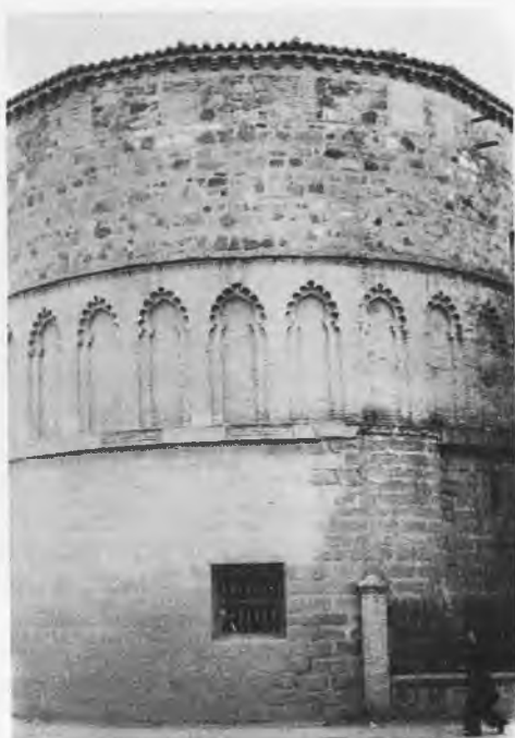
28. SAN LÁZARO. Exterior del ábside.
