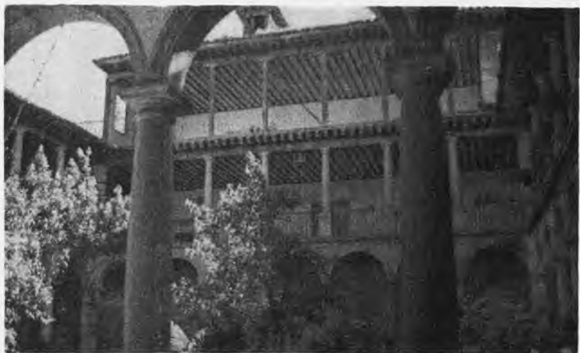
San Clemente el Real.—Claustro, lado Este
