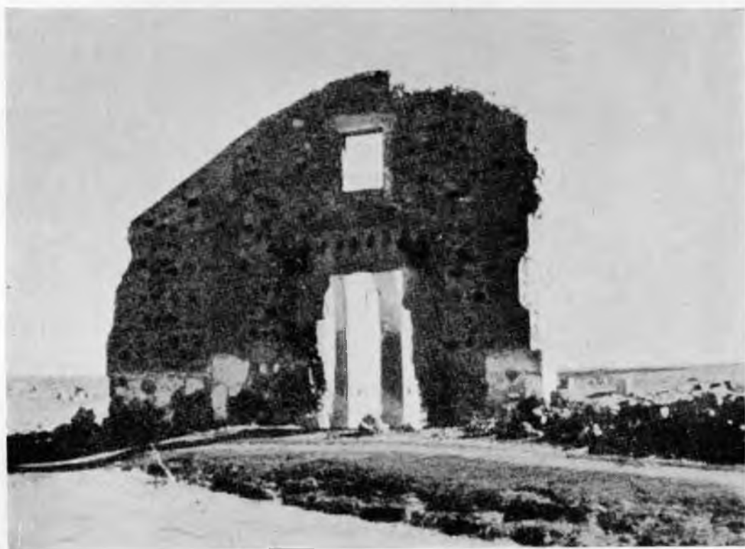
Restos de la casa de la encomienda en Yegros.
