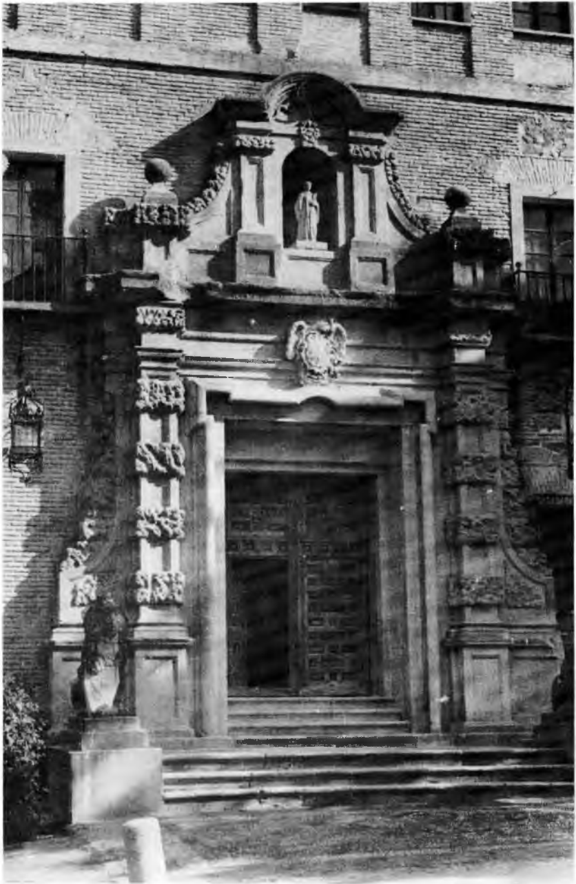
Portada barroca del convento de bernardos de Monte Sión
